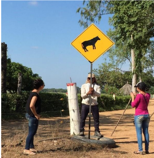
Figuras 5. Instalación de señales preventivas
