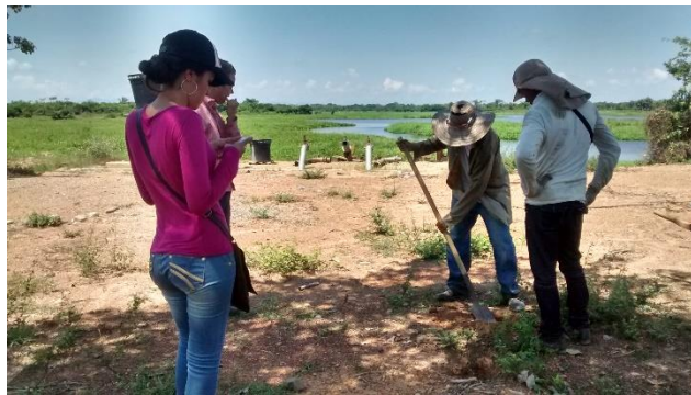
Figura 8. Preparación del terreno
