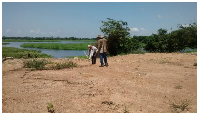
Figura 16. Preparación del suelo
