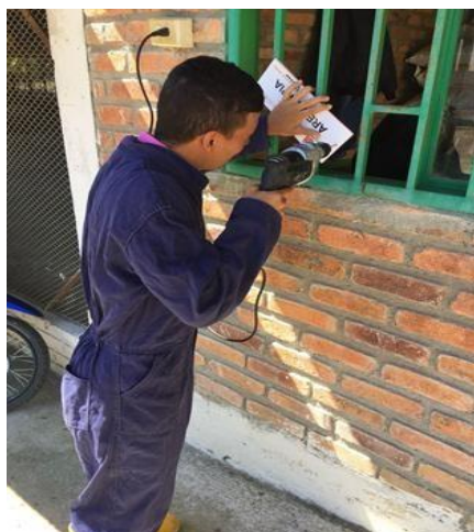
Instalación de la señalización.
