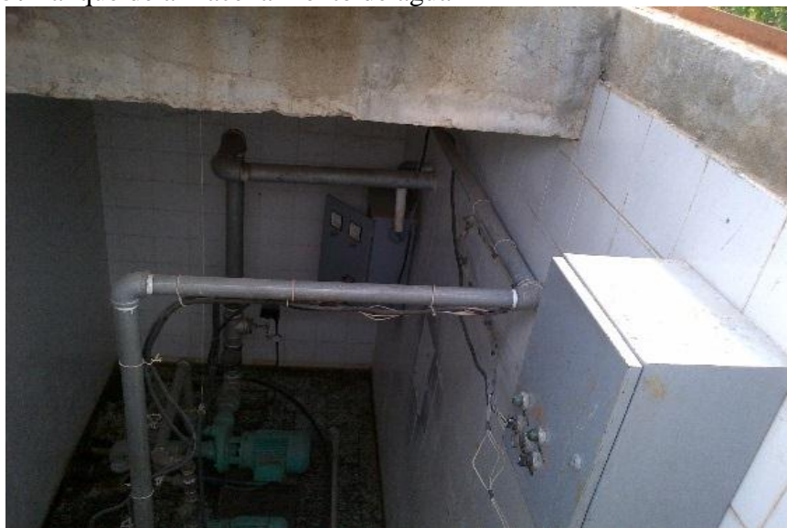
Fotografía 5: Tanque de almacenamiento de agua
