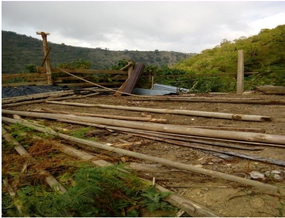
Establo perteneciente a la casa
