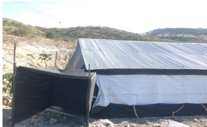
Figura 22. Entrada ventilación al galpón Fuente: Pasante
