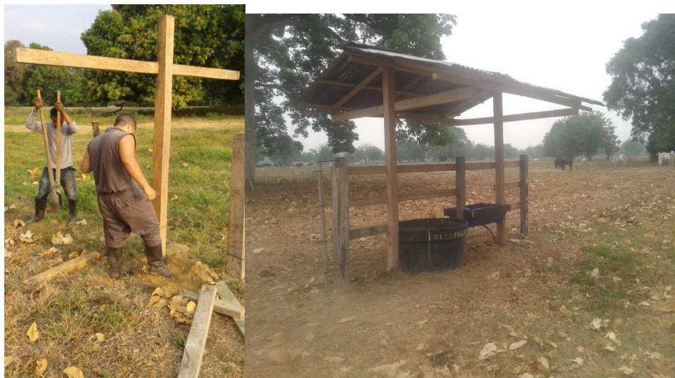
Figura 7. Construyendo el saladero y el bebedero
