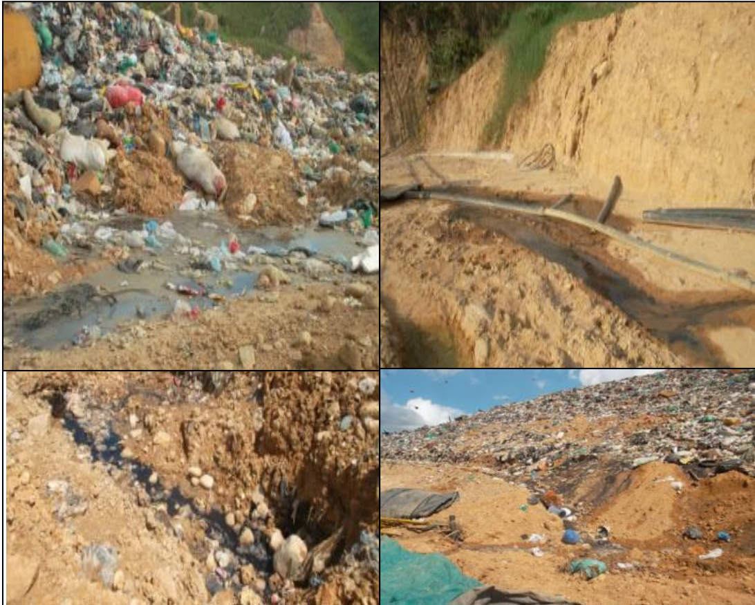
Fotografía 2. Brotes de lixiviados.
