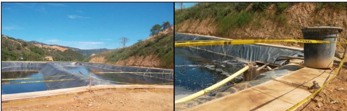
Fotografía 10. Pondajes del sistema de lixiviados.
