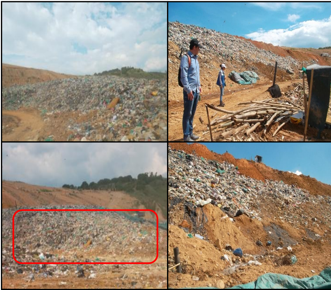
Fotografía 1. Residuos sólidos dispuestos sin cobertura.
