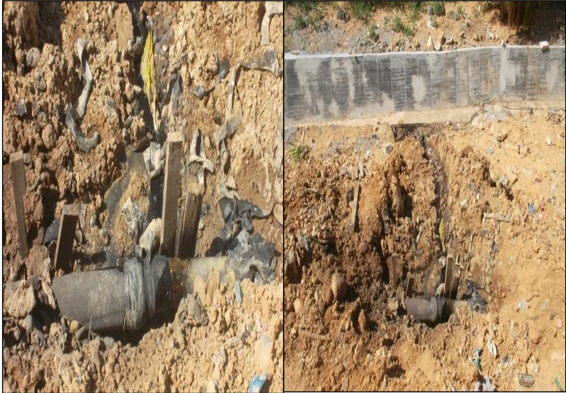
Fotografía 4. Reparación provisional de la conducción
