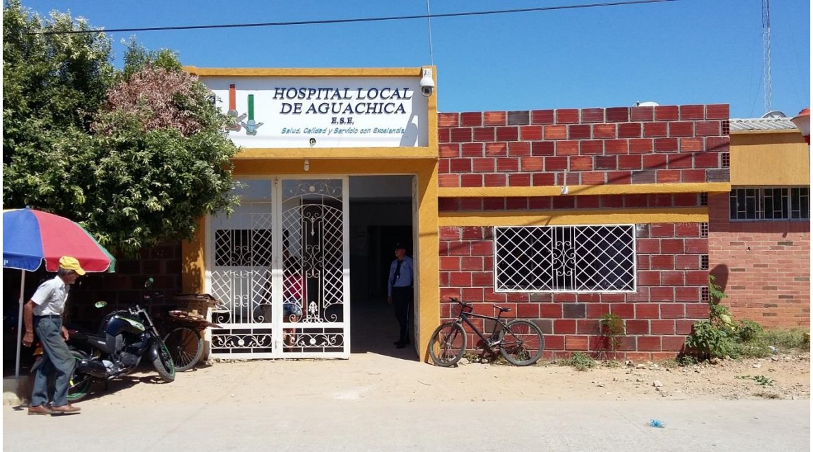
Fotografía 1. Visita de Campo
