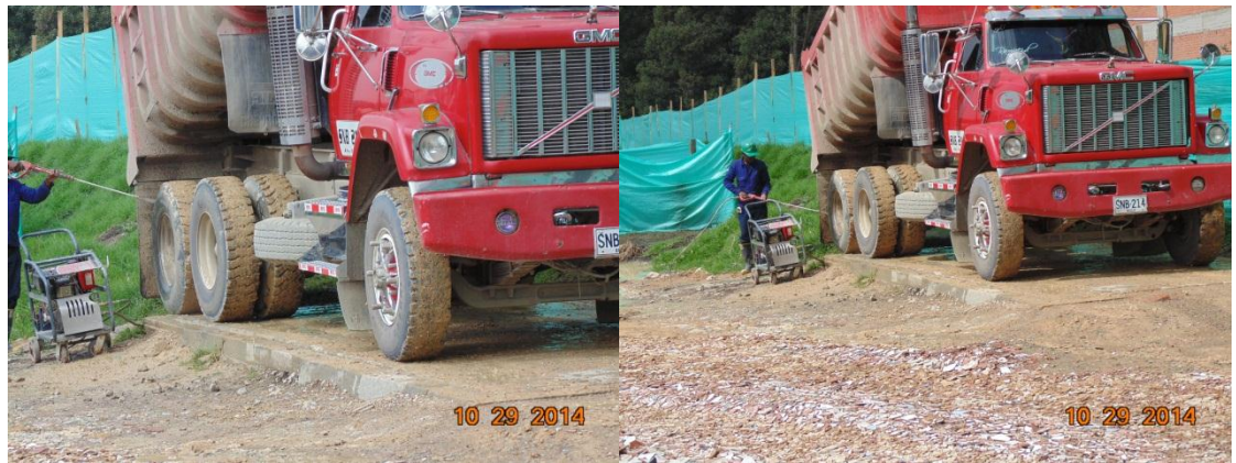
Foto 15. Lavado de llantas de volquetas.
