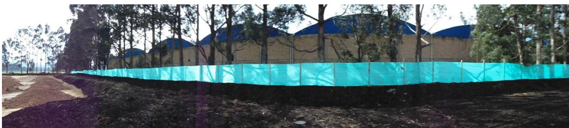
Foto 9. Cerramiento del costado occidental.
