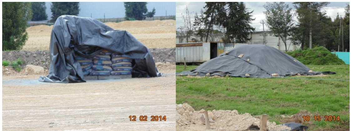
Foto 16. Material en el frente de obra cubierto.
