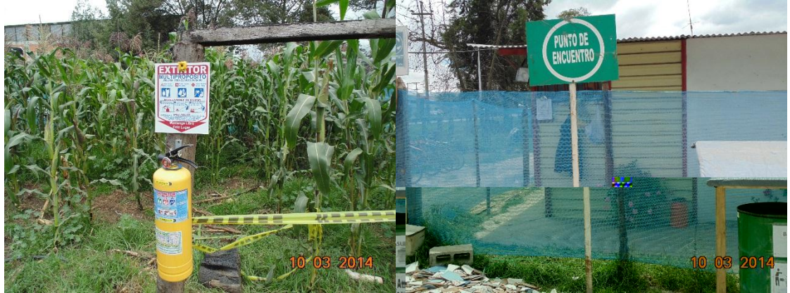
Foto 11. Señalización interna de la obra.
