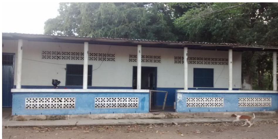
Figura 5. Vivienda del administrador general. Fuente. Pasante del proyecto
