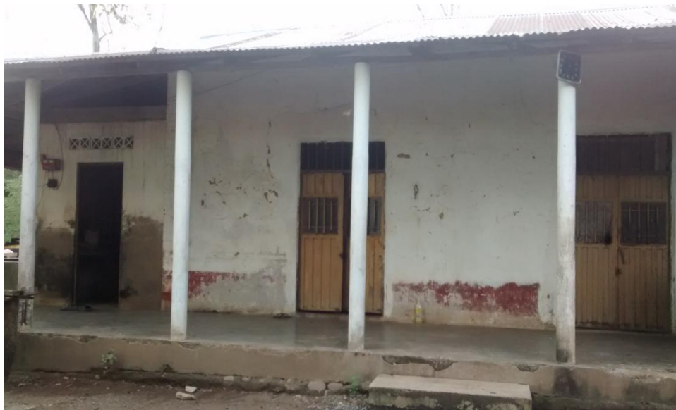
Figura 6. Vivienda de los trabajadores varios y usados como bodega. Fuente. Pasante del proyecto
