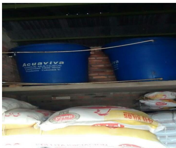
Foto 11. Tanques de 1.000 lt para cada galpón.
