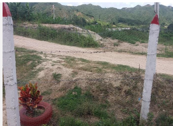
Foto 4. Postes pintados, adecuación de cerca y mallas.
