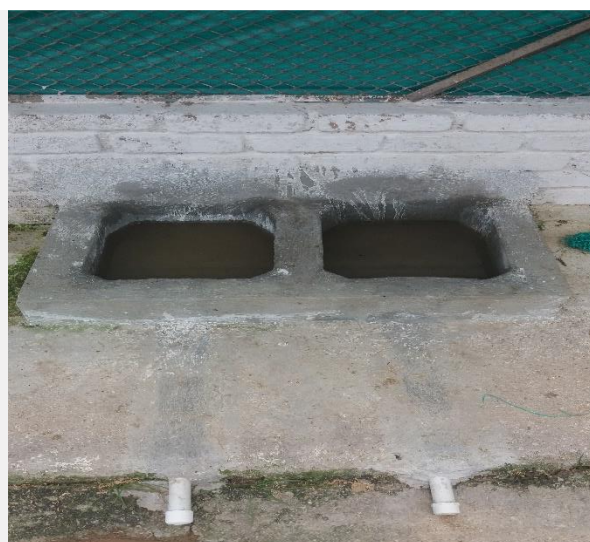
Foto 16. Instalación de nuevos pediluvios.
