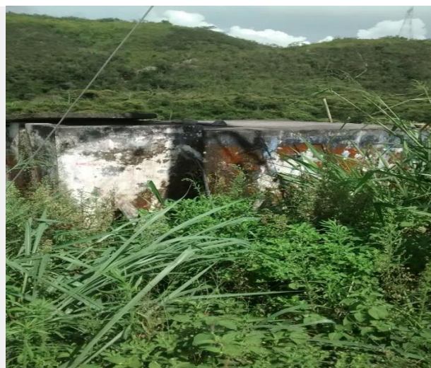
Foto 10. Almacenamiento de agua no potable.
