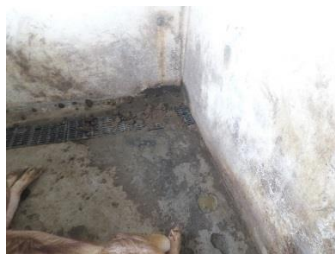
Figura 22. Drenaje en corral de verracos con rejilla metálica.
