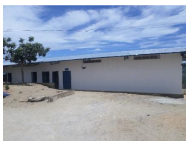
Figura 36. Bodega de alimento y oficina.
