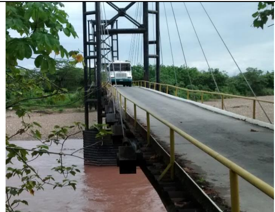
Fotografía 7 Punto de control del Municipio de Veracruz Fuente: Pasante
