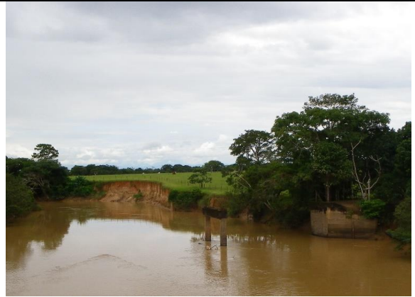
Fotografía 3 Punto de control del Municipio de Cabuyaro Fuente: Pasante
