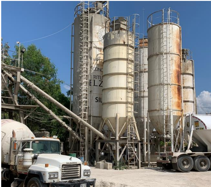
Silos Concretos & Triturados El Zulia
