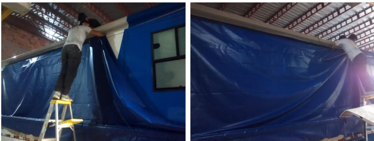
Figura 10. Instalación Carpas nuevas.
