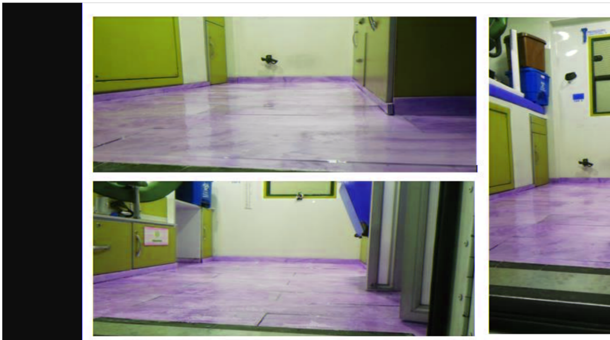
Figura 4. Instalación Nuevo Piso en los consultorios.
