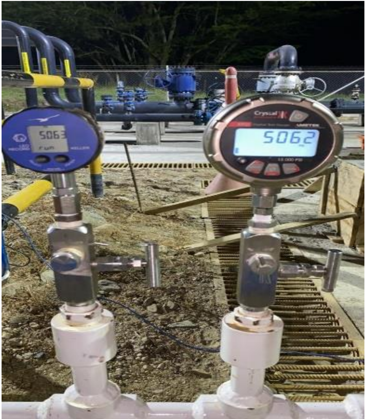
Figura 16 Prueba hidrostática a tubería
