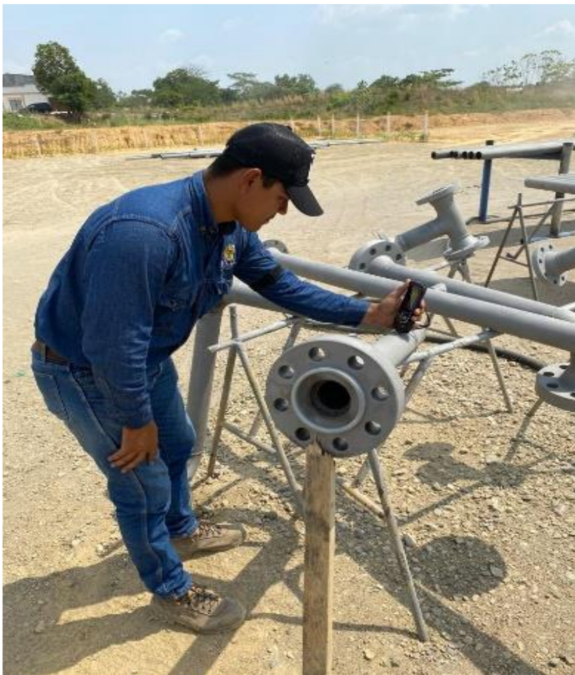
Figura 17 Medición perfil de anclaje
