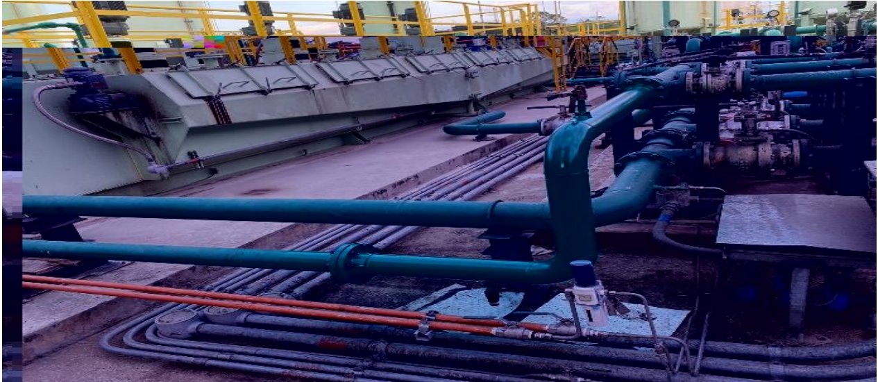
Figura 23 Inspección visual de spool
