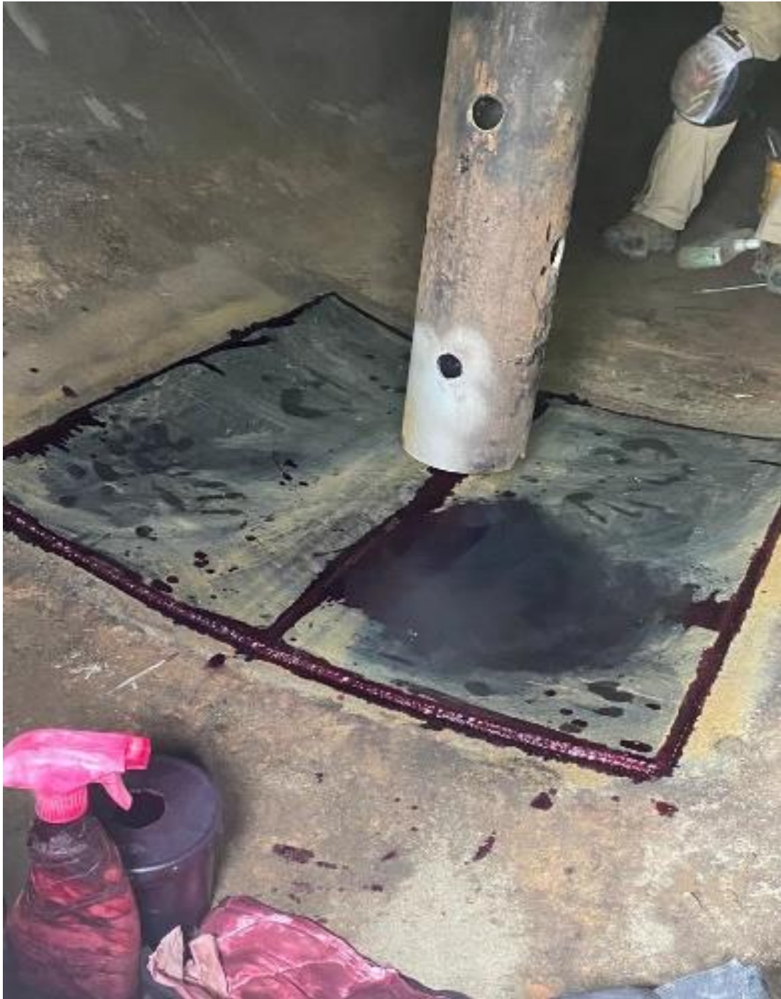
Figura 20 Ensayos no destructivos (tintas penetrantes)
