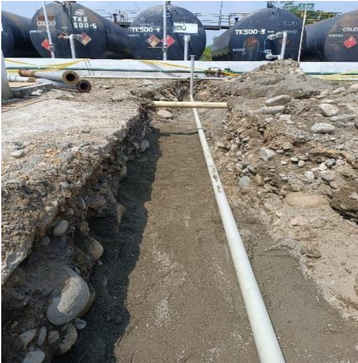
Figura 26 Cama de arena para integridad de tubería
