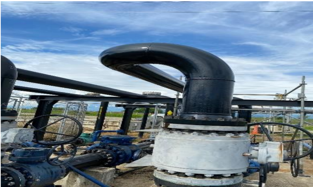
Figura 24 Inspección visual de spool
