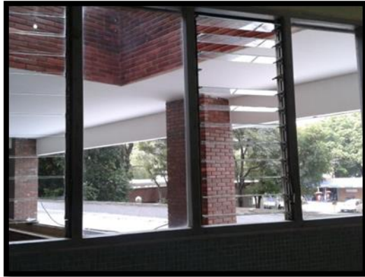
Foto 4: ventanas de la E.S.E HUEM
