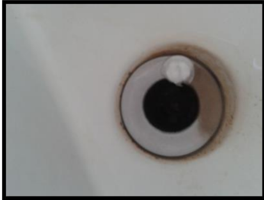
Foto 19: lavamanos con sifón sin rejilla
