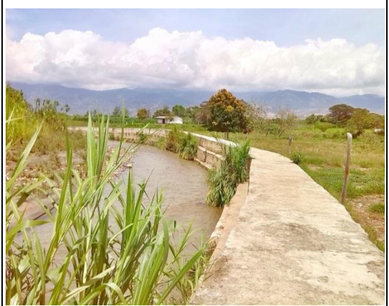
Muro en gaviones revestido en concreto- Vereda Llano Alto
