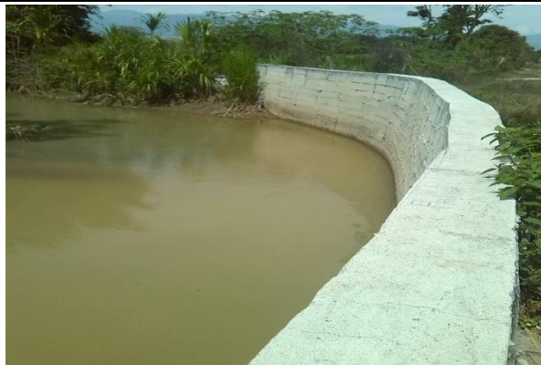
Muro de contención - Vereda El Hoyo
