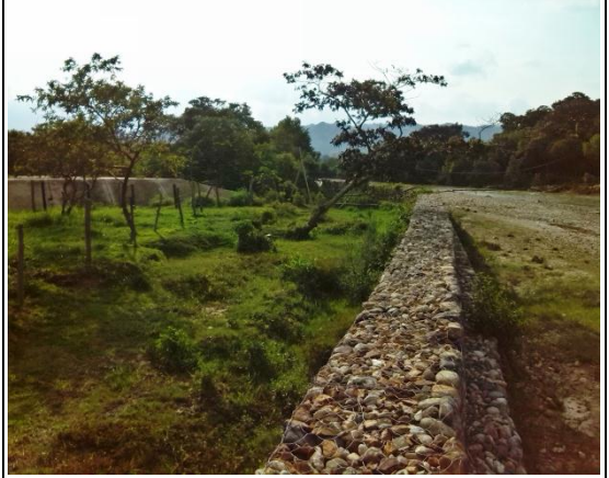
Muro en gaviones- Laguna de Oxidación Abrego
