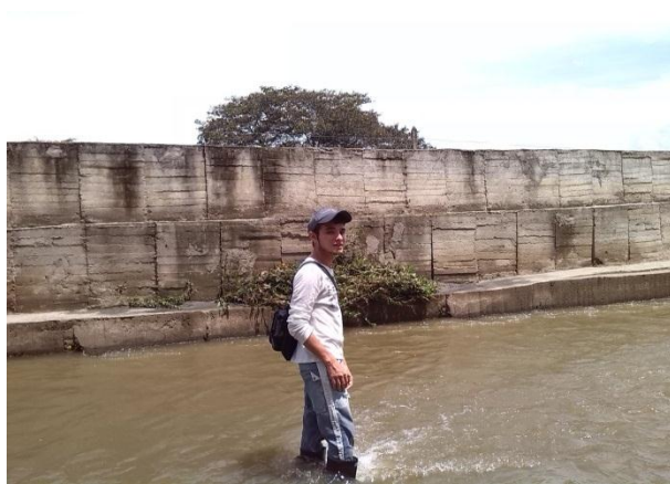
Muro en gaviones revestido en concreto- Vereda Llano Alto
