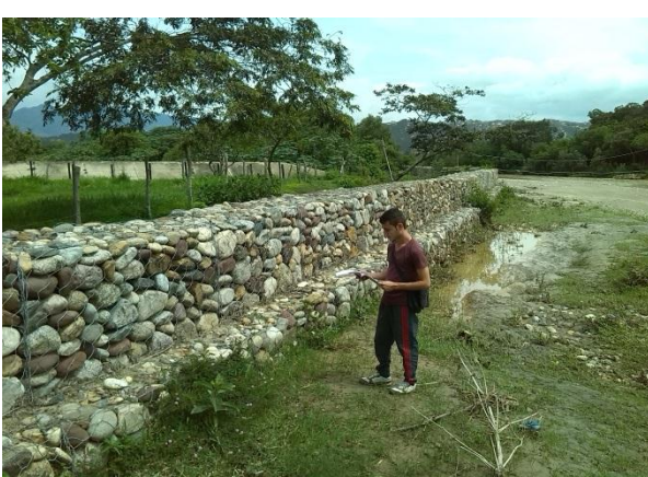
Muro en gaviones- Laguna de Oxidación Abrego
