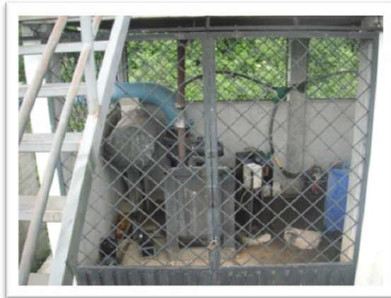
Imagen 3. Máquina para bombear las aguas residuales de la zanja.
