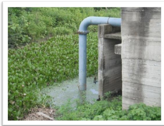
Imagen 4. Sistema de captación del agua residual en la zanja.
