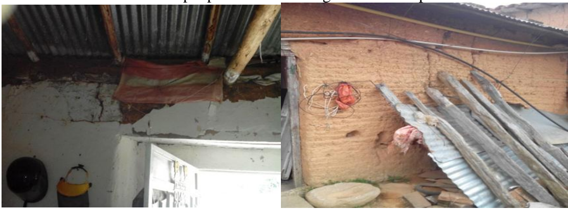
Estilo de construcción de tapia pisada en el corregimiento de aspásica.
