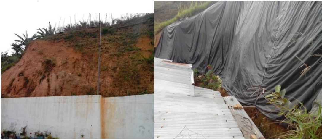
Estilo de protección de los taludes en el terreno
