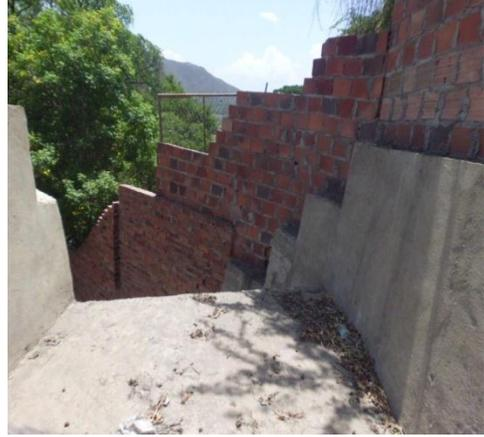
**Fotografía N° 11 Construcción de gradas disipadoras en el sector Manzana 32**
