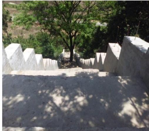
**Fotografía N° 12 Gradass disipadoras en el sector Manzana 19**
