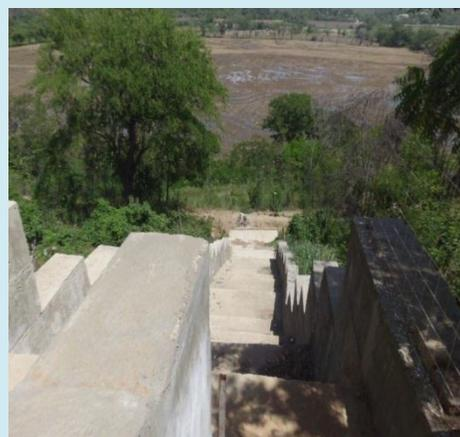
**Fotografía N° 14 Gradass disipadoras en el sector Manzana 7 y 9**
