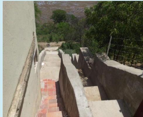
**Fotografía N° 15 Gradass disipadoras Manzana 11 Con Calle 20**
