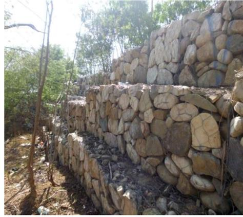
**Fotografía N° 17 Construcción de gaviones –Barrio la Esperanza**
