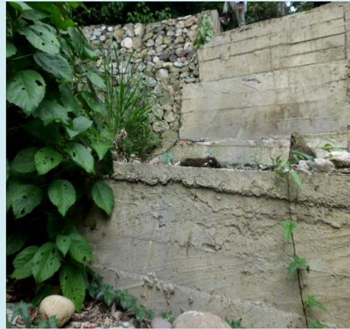
**Fotografía N° 31 Construcción de gaviones-muro de contención y gradas disipadoras en el sector donde se presentó pérdida de Banca.**
