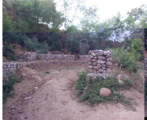
**Fotografía N° 21 Construcción de gaviones para protección de viviendas en la Av. 3 que pueden verse afectadas si se presenta una inundación**
