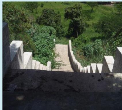
**Fotografía N° 13 Gradass disipadoras en el sector Manzana 7 Y 9**
