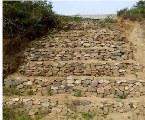
**Fotografía N° 30 Construcción de gaviones y placas huellas a la altura de la vereda los Mangos.**
