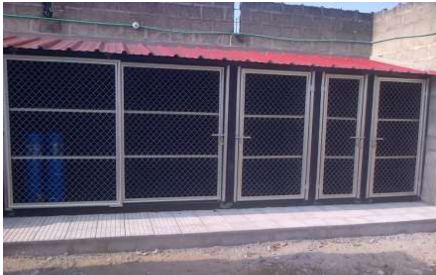
Centro de acopio de residuos peligrosos.
