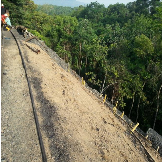
Estabilización por medio de trinchos.
