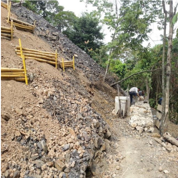
Construcción de muro en gaviones
