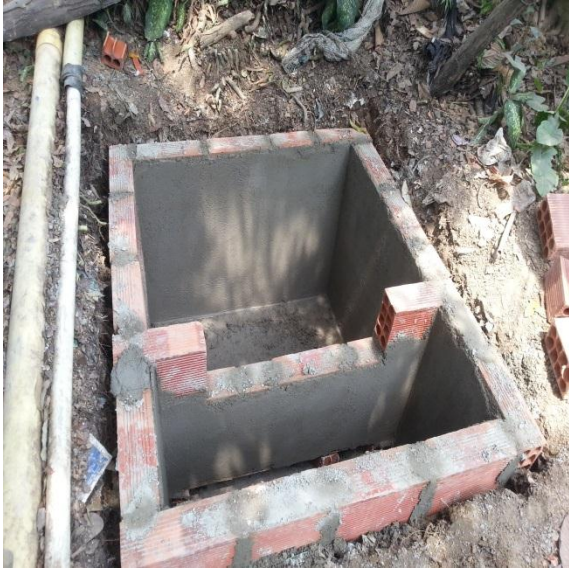
Tratamiento con M.O Biorremediadores.
