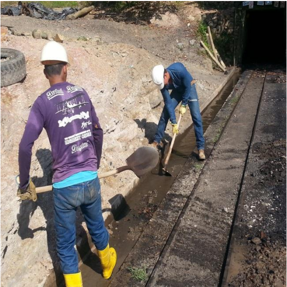
Mantenimiento canales perimetrales.
