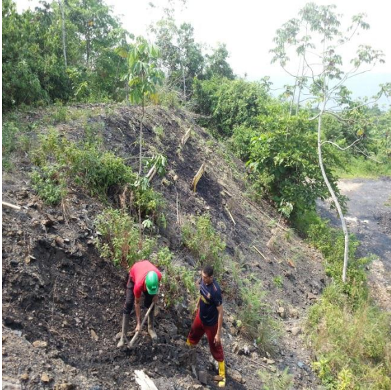
Perfilado del talud.
