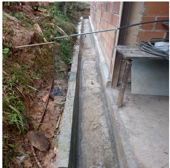
Construcción de canales perimetrales.
