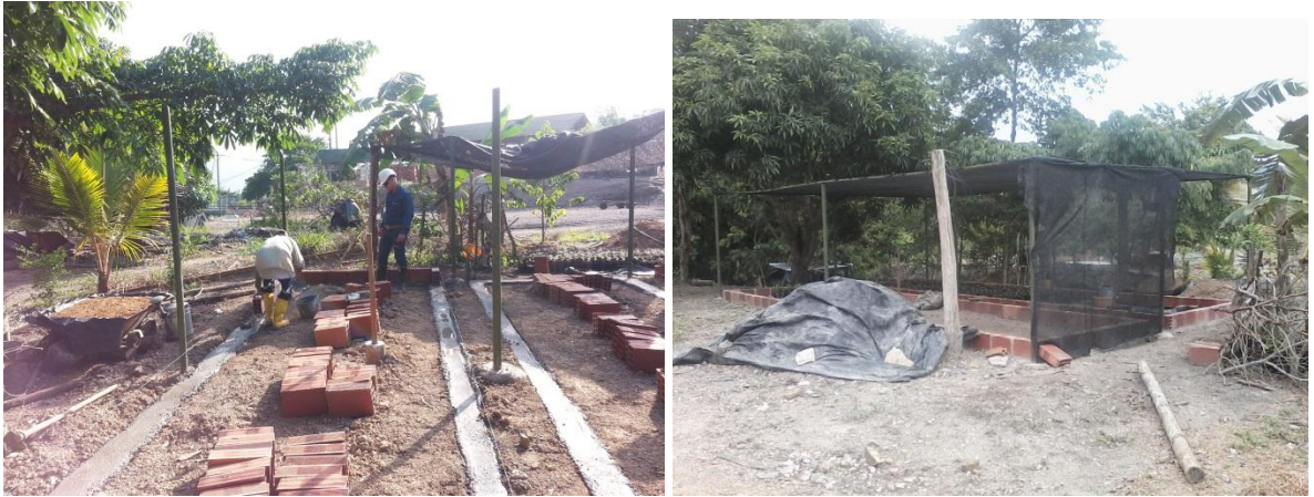
Fotografía 9. Construcción vivero forestal San Carlos
