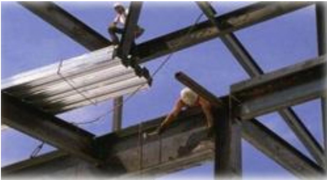
Figura 18. Construcción en metal
