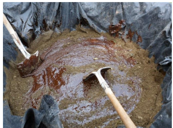
mezcla de guácimo hasta homogenizar
