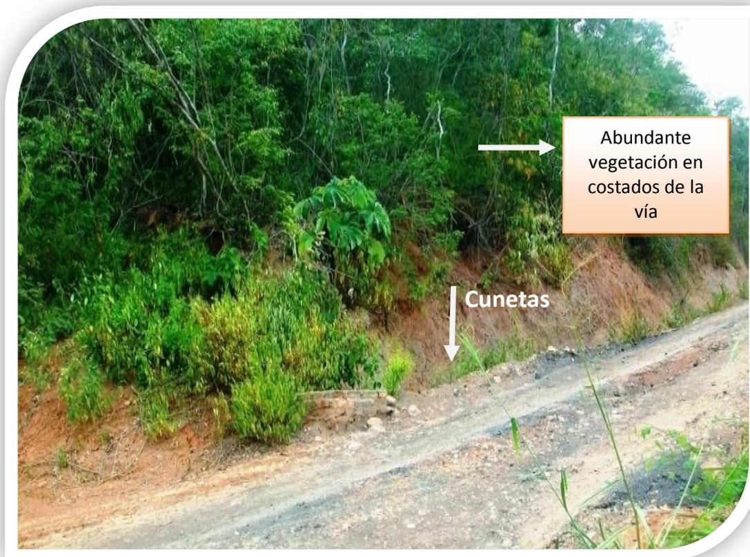
*La vía de acceso a la mina se encuentra en buen estado, se puede observar en la imagen que cuentan con cunetas de conducción de aguas para evitar el deterioro de la vía, el tránsito constante de volquetas a compactado el terreno lo que garantiza que la vía tiene estabilidad. Se logra apreciar que hay la vegetación en el área no intervenida en la apertura de la vía es abundante.*
