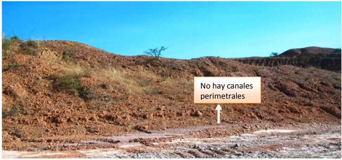
*En las fotografías se puede observar que el botadero de estériles carece de canales de perimetrales; se logra evidenciar que se inició un proceso de regeneración vegetal naturalmente donde las condiciones del suelo lo permitieron.*
