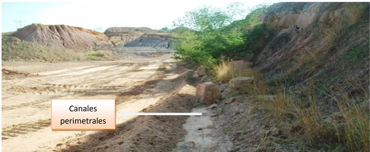
*Como se puede observar en el registro fotográfico la zona de disposición del mineral no tiene canales perimetrales diseñados con profundidad para la conducción de aguas de escorrentía, en algunos sitios se observa cárcavas profundas las que evidencian meteorización por el agua de la zona.*
