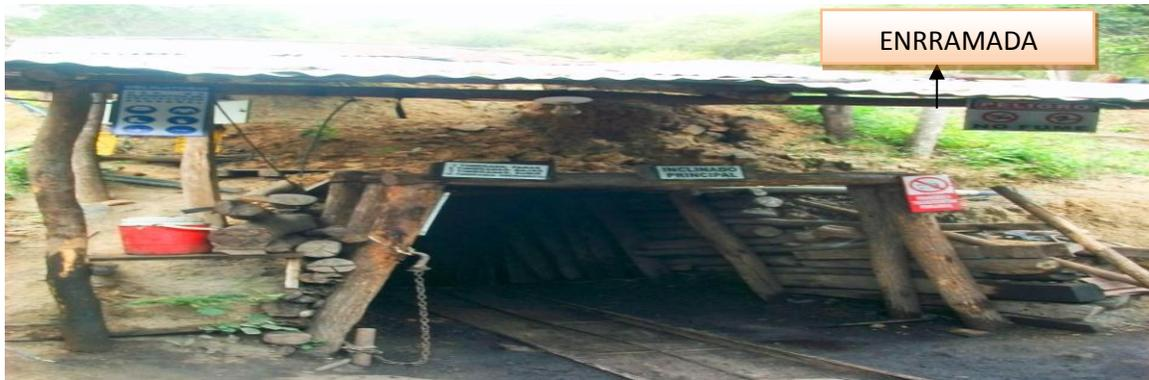
Como se evidencia en la imagen la bocamina esta reforzada en madera, tienen las guías de madera para la compra de la misma; la bocamina está recubierta por una enrramada hecha en zin para que cuando llueva el agua de escorrentía no ocasione movimientos de tierra y penetre al interior del yacimiento.
