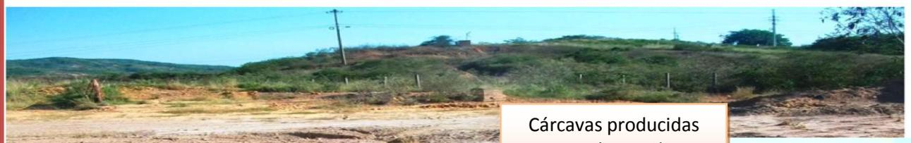
*Como se observa en las fotografías no hay canales de coronación, evidencia de esto es la presencia de cárcavas, causadas por el agua de escorrentía que no tiene ningún sistema de conducción.*
