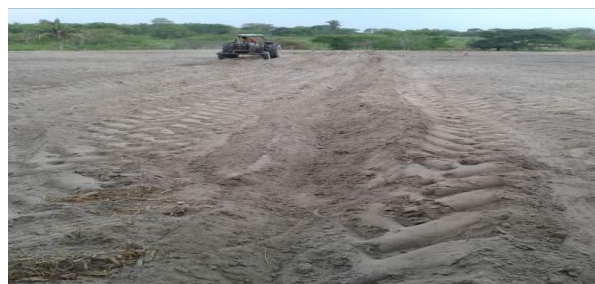
Imagen 15. Preparación del terreno.
