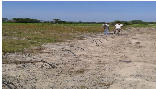
Imagen 17. Preparación del terreno.
