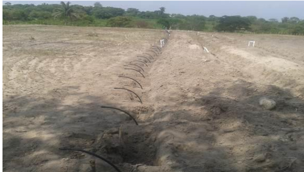
Imagen 16. Preparación del terreno.
