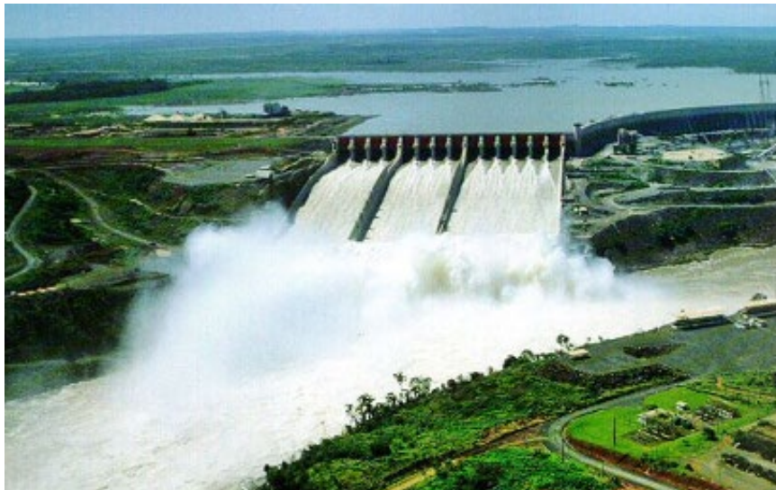
Hidroeléctrica del río Jimenoa
