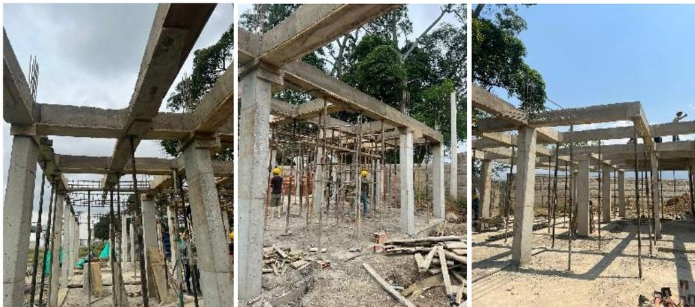
**3.1.2.18 Armado de placa.** En la ejecución de esta actividad, es de suma importancia el correcto tranque de la placa, empleando un buen número de parales, se inicia con la extensión de la lámina de Metaldek y seguidamente la ubicación de la malla electrosoldada, finalizando con el testereo de los laterales. Es de suma importancia dejar los pasantes que proyectan la tubería de los bajantes sanitarios de los pisos superiores. (Ver figura 21)
