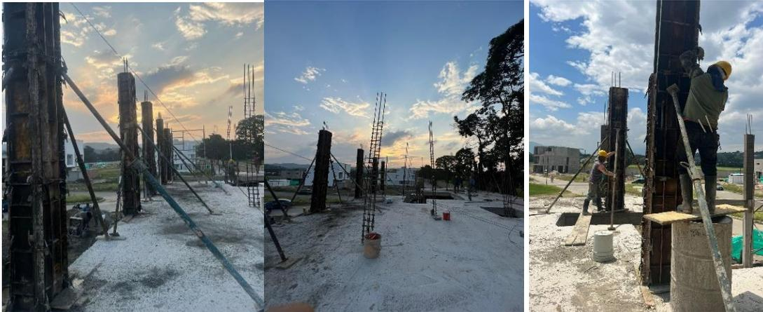
**3.1.2.22 Replanteo y levantamiento de mampostería.** Para iniciar actividades de mampostería es necesario tener en cuenta los siguientes criterios: inicialmente asegurarse de que la superficie donde se van a levantar los muros este limpia sin nada que impida realizar el replanteo, este se realiza según planos arquitectónicos los cuales indican la ubicación y dimensión del muro; adicionalmente es importante tener claro la ubicación de puertas, ventanas y dinteles.
