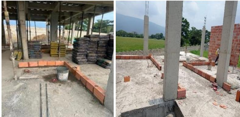
A medida que se va agregando mezcla a la junta se debe estar limpiando el exceso lo que queda en los bordes, al terminar cada hilada de bloque nuevamente se colocan los bloques maestros y el hilo para que sea una guía y seguir con el mismo procedimiento hasta obtener la altura deseada. La dosificación utilizada es 1:4, por cada porción de cemento agregamos 4 porciones de arena triturada. (Ver figura 26)
