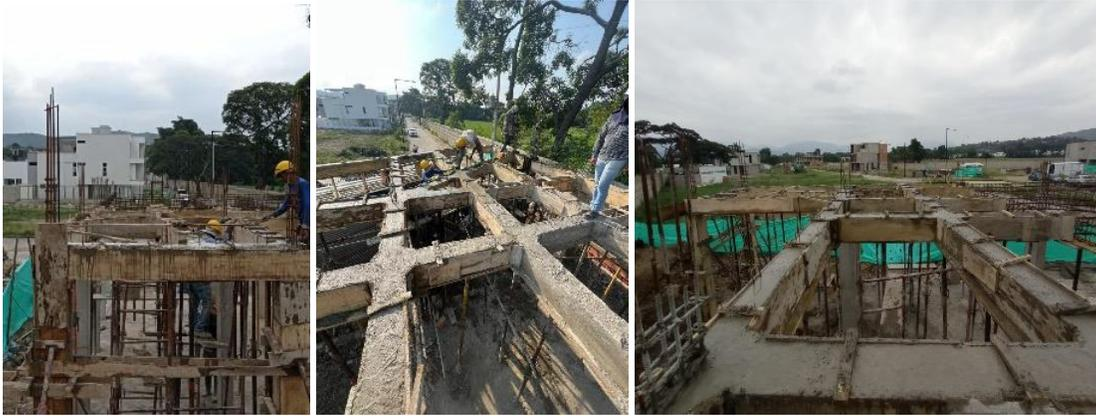
**3.1.2.17 Desencofrado de vigas entrepiso.** Al pasar 12 horas de tener las vigas vaciadas se procede con la desencofrada y durante los próximos 7 días se procede a incorporar el agua suficiente esto se hace con el fin de que el concreto no pierda humedad y brinda la resistencia máxima que se está esperando. (Ver figura 20)
