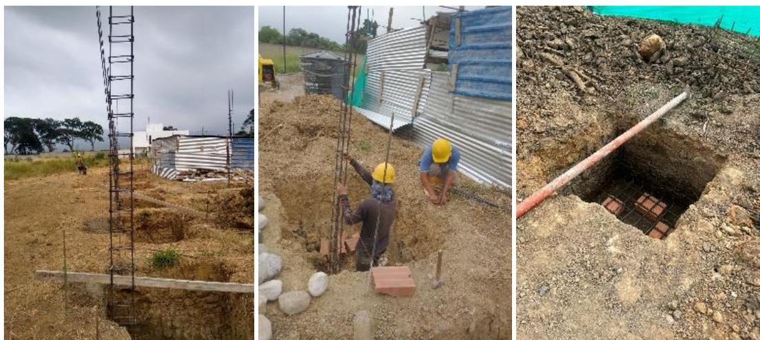
**3.1.2.6 Vaciado de zapatas y pedestal.** El vaciado de zapatas se realiza con un concreto realizada in situ, este es ejecutado por los maestros teniendo en cuenta una resistencia de 3000 psi, posteriormente el armado del pedestal el cual se realizó con bloque y los cuales se fundieron con la misma dosificación. (Ver Figura 9)
