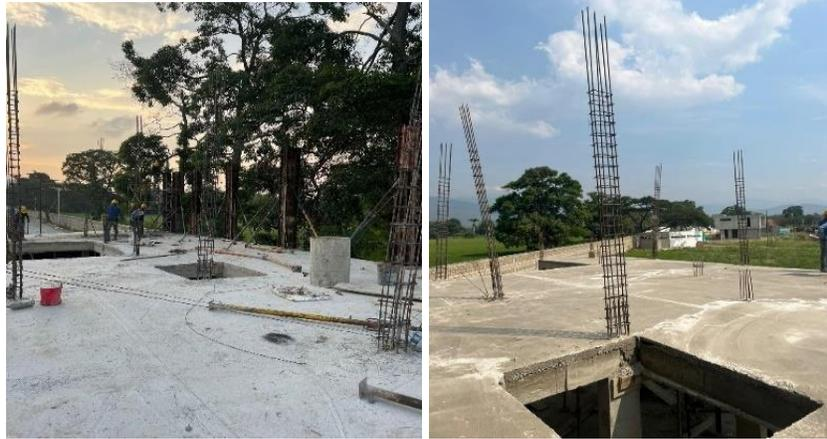
**3.1.2.21 Encofrado y vaciado columnas segundo piso.** Se realiza el encofrado de las columnas con formaleta industrializada verificando que estén con aceite quemado y se procede a fundir. Luego de 12 horas se empieza con el desencofrado de columnas y durante los próximos 7 días se proporciona suficiente agua para mantener el fraguado y lograr su máxima resistencia. ver figura 24.
