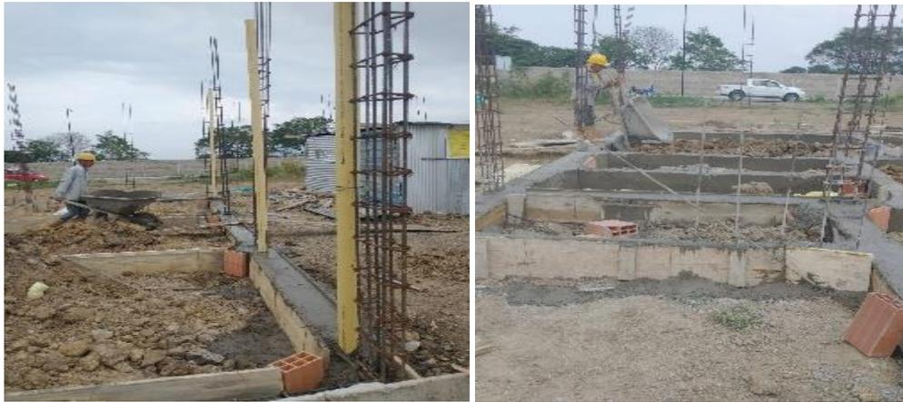
**3.1.2.11 Desencofrado de vigas y nivelación ante piso.** Una vez transcurridas 12 horas del vaciado se empieza a desencofrar las vigas de arrastre e inicia la nivelación del ante piso y ubicación de malla electrosoldada, para su posterior vaciado. (Ver Figura 14)
