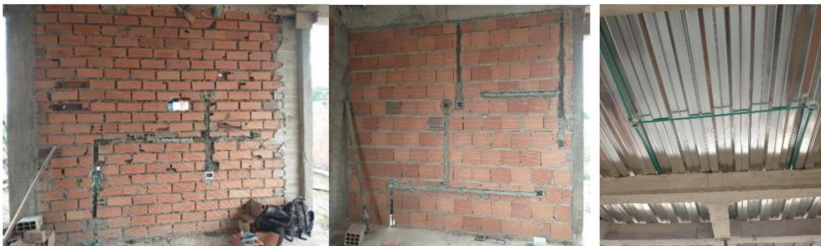
**3.1.2.24 Instalación de tubería hidráulica y sanitaria.** Al igual que la tubería eléctrica, se procede con las instalaciones de la red hidráulica y sanitaria en cada uno de los espacios dispuestos para la alimentación y desagüe de agua, todo acorde a los planos del proyecto. (Ver figura 28)
