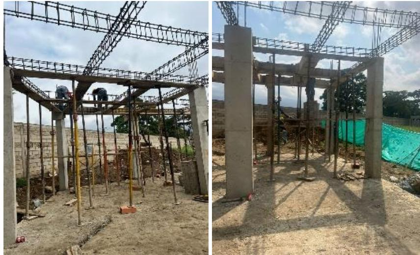
**3.1.2.16 Encofrado y vaciado de vigas entrepiso.** Una vez ubicadas cada una de las vigas, se procede a encofrarlas utilizando tablas de construcción, esta formaleta debe tener aceite quemado o acpm con el fin de que el concreto no se pegue a ella y facilite el poder desencofrarlas una vez fundidas. (Ver figura 19)
