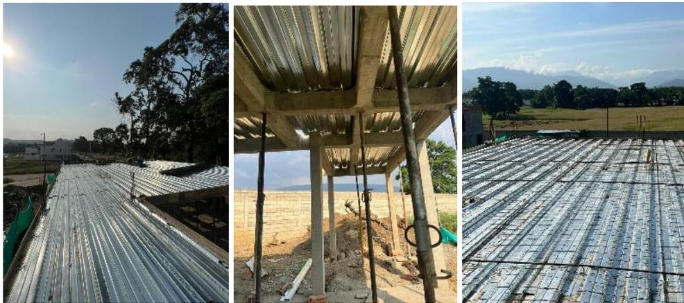
**3.1.2.19 Vaciado de placa.** Una vez lista la placa se procede al vaciado de esta. Al pasar 12 horas después de fundida la placa se procede al desencofrado de los bordes laterales y transcurrido 15 días se procede al destranque de la misma, durante los próximos 7 días de fundida se le proporciona la suficiente agua para mantener el fraguado del concreto. (Ver figura 22)
