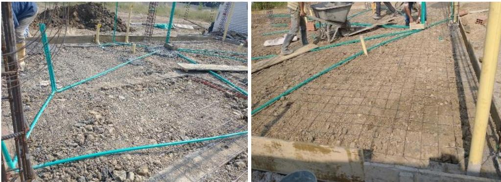
**3.1.2.13 Vaciado de ante piso.** Posterior al replanteo del ante piso, junto con los pasantes sanitarios y eléctricos, se da inicio seguidamente a realizar un testereo o encoframiento lateral para dar inicio al proceso de vaciado, el cual se realiza con concreto premezclado. (Ver Figura 16)
