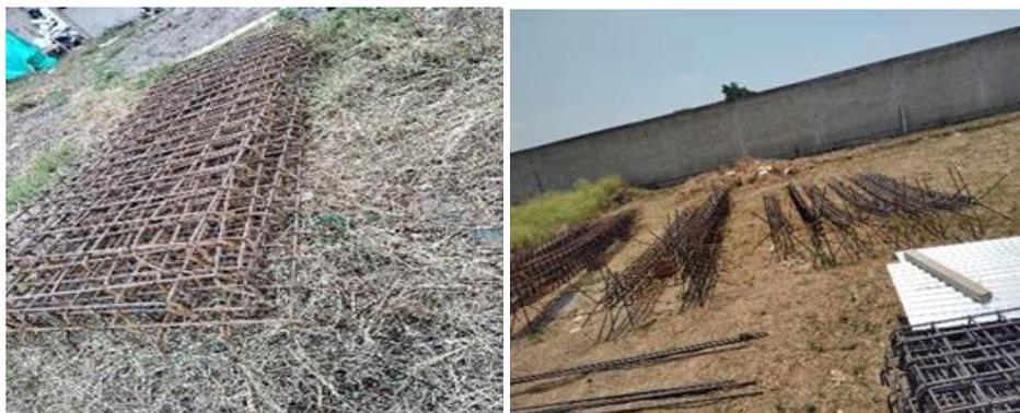
**3.1.2.5 Ubicación de columnas y parillas.** Una vez armados los elementos se procede a ubicar las parrillas en las excavaciones y seguidamente cada columna en cada zapata, teniendo en cuenta la ubicación de las columnas si son centradas o corridas. (Ver Figura 8)
