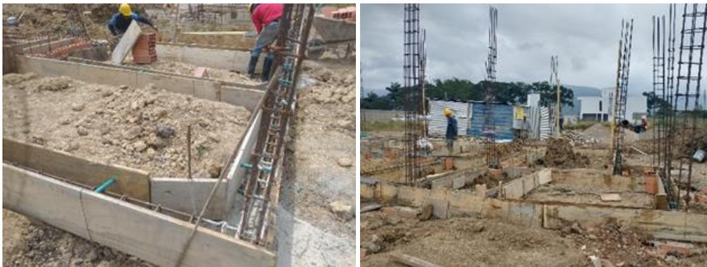
**3.1.2.10 Vaciado de vigas.** Para el vaciado de vigas se utilizó concreto de 3000 psi ejecutado in situ. A medida que se va fundiendo es importante ir vibrando las vigas con el objetivo de que no queden porosidades y obtener una mayor resistencia. (Ver Figura 13)
