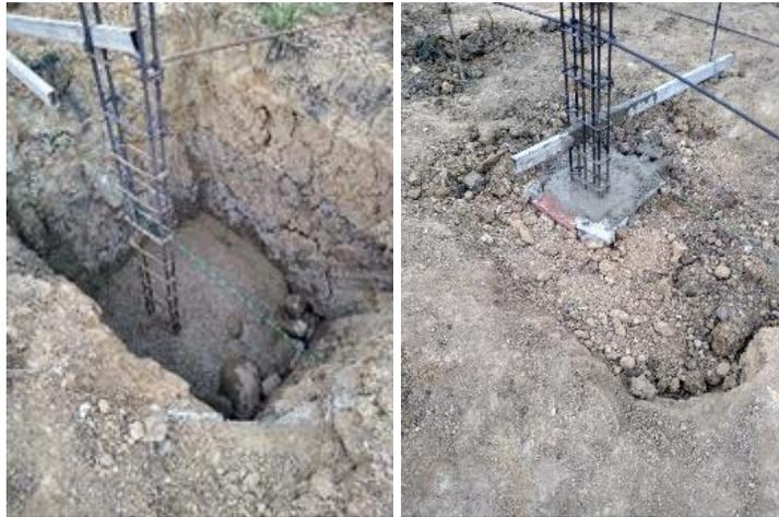
**3.1.2.7 Armado y ubicación de vigas de cimentación.** Para el armado de vigas es importante tener en cuenta traslapos entre vigas, diámetro del acero, distancia de separación entre estribos. Las vigas de cimentación son elementos estructurales muy resistentes los cuales conectan las zapatas y conforman el esqueleto de cualquier edificación; las cuales tienen la resistencia de soportar cargas y momentos. (Ver Figura 10)
