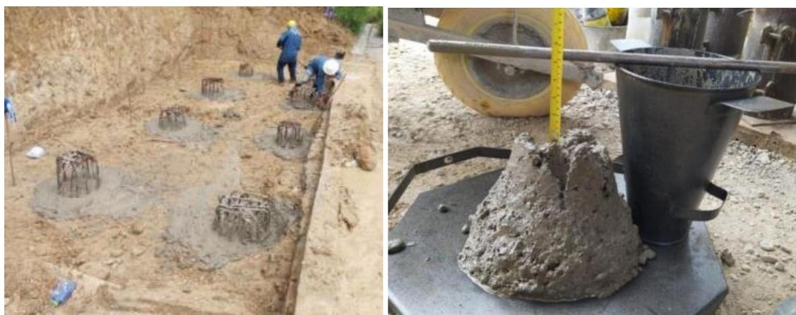
*Nota.* La figura representa la fundida de 8 pilotes con concreto de 4000PSI en el sector de la colina y el ensayo de asentamiento realizado. *Fuente.* CLS INGENIERIA SAS.
