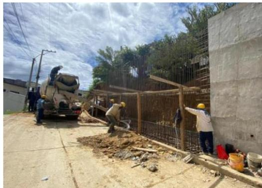
Fundida de zarpa de segundo módulo con concreto de 4000 psi en La Colina.
