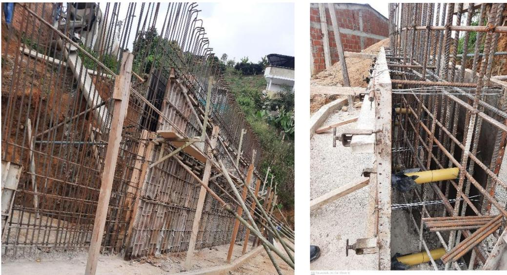
*Nota.* La figura representa Ajuste y colocación de formaleta metálica y incrustación de lloraderos
