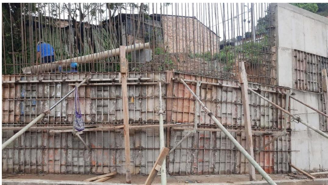
*Nota.* La figura representa Fundición de la segunda sección de alma del tramo 1 con concreto de 4000 psi en San Miguel II. *Fuente.* CLS INGENIERIA SAS.
