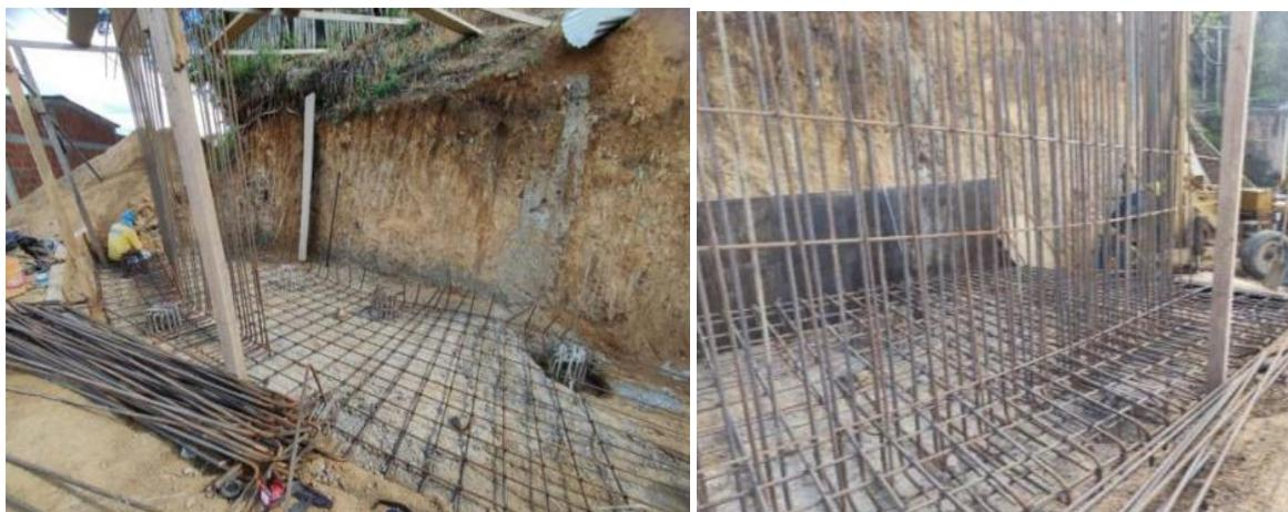
*Nota.* La figura representa el armado de acero de refuerzo para zarpa y alma del muro en el primer tramo del sector de San Miguel II. CLS INGENIERIA SAS
