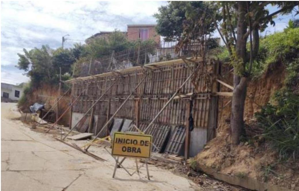
Nota: la figura representa el retiro de formaletas de la primera sección del muro Fuente: CLS
