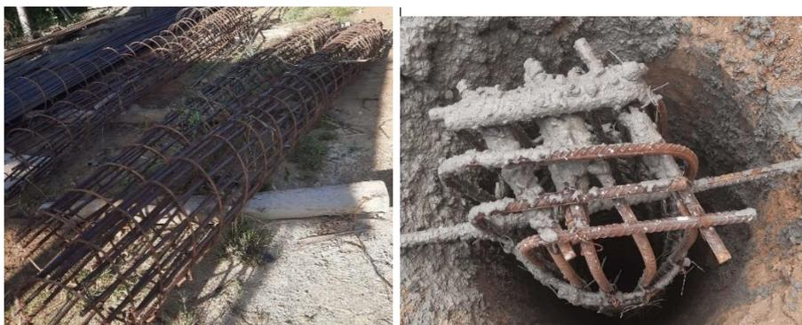
*Nota.* La figura representa el armado de canastillas en acero para los pilotes en el campamento y colocación de la canastilla. *Fuente.* CLS INGENIERIA SAS
