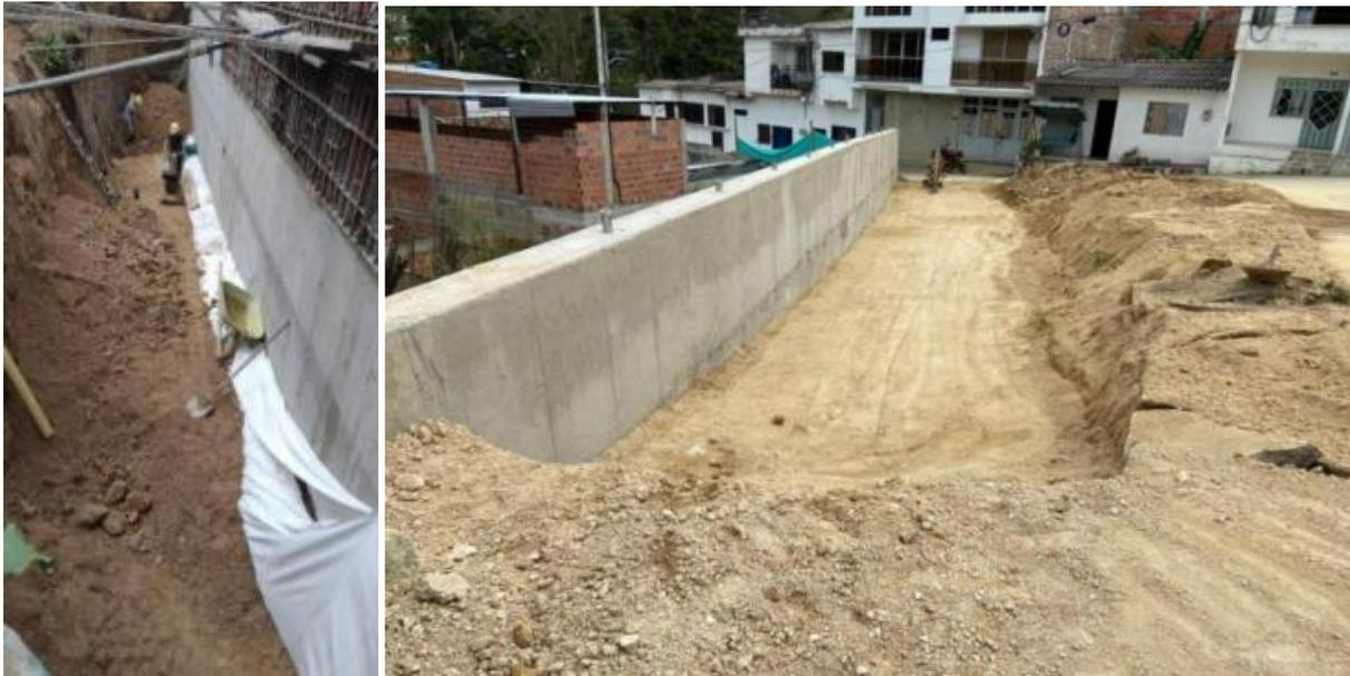
Nota: la figura representa la instalación del geotextil de drenaje profundo. Fuente: CLS
