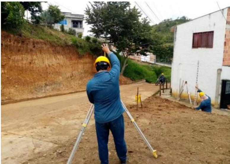
*Nota.* La figura muestra la actividad de la localización topográfica de eje de pilotes en el sector “la colina” *Fuente.* CLS INGENIERIA SAS
