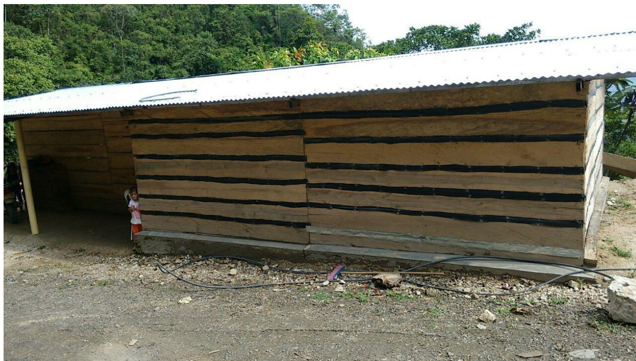
Figura 15. Casa ubicada en las entradas del Tarra. Fuente: Autores
