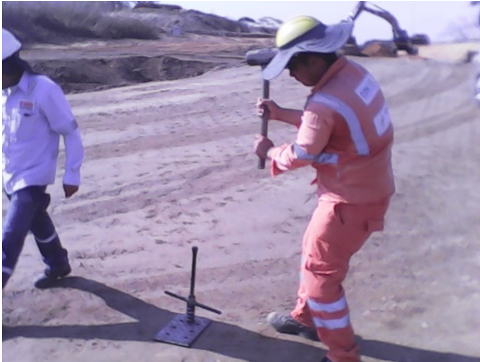
Fotografía 12. Ensayo de Densidad
