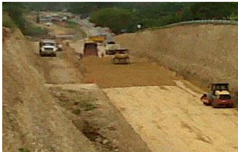
Fotografía 10. Capa de Terraplén
