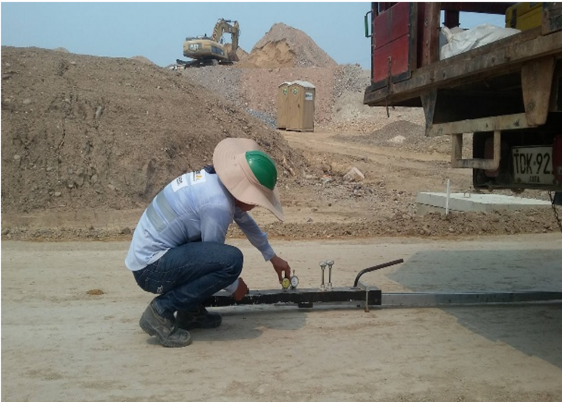
Fotografía 13. Ensayo de Viga Benkelman
