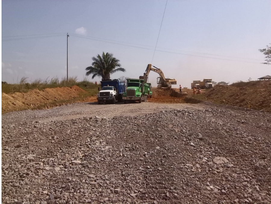
Fotografía 7. Capa de Mejoramiento
