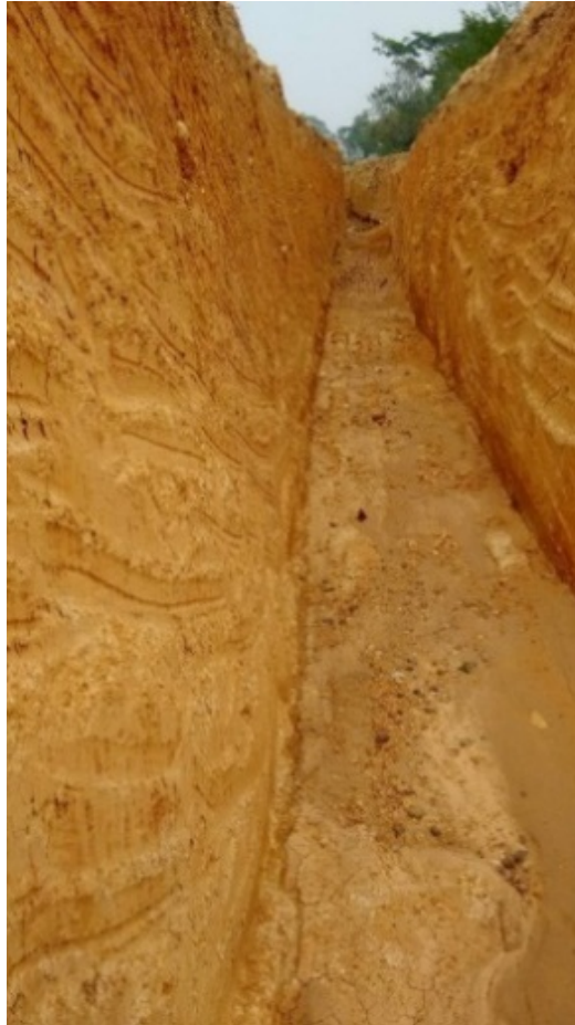
Fotografía N° 5. Canal para Aguas Lluvias
