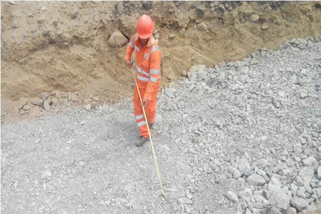
Fotografía 8. Control de Nivel en Relleno
