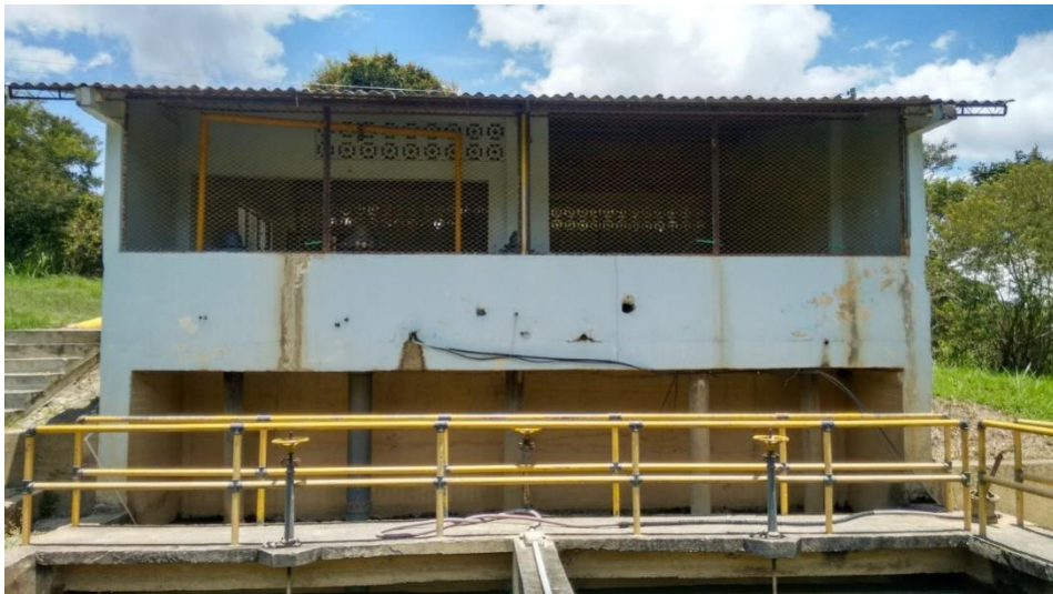
Estación de bombeo de baja cabeza, ESPO S.A.
