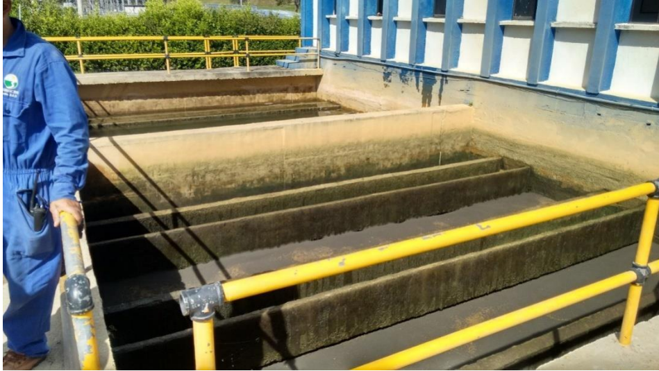
Panorámica 5 mantenimiento terminado, ESPO S.A.
