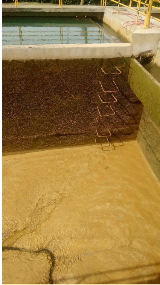
Panorámica 7 escalones de acceso a sedimentador para mantenimiento, ESPO S.A.
