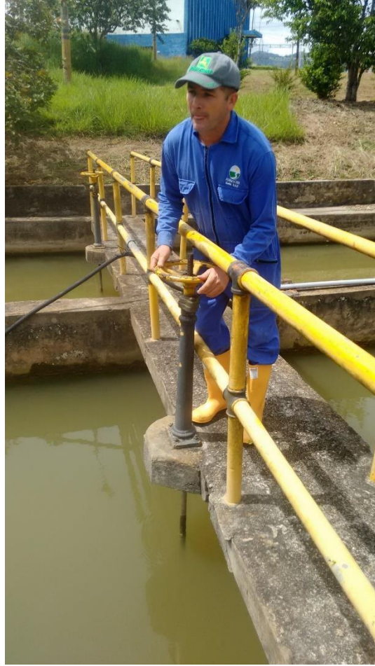
Panorámica 3 Operario manipulando la compuerta de desagüe, ESPO S.A.
