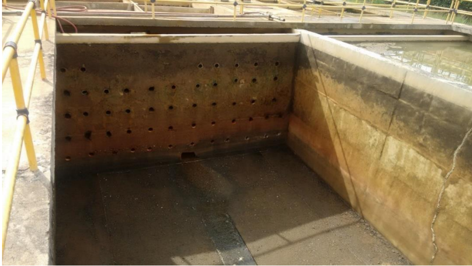
Panorámica 11 Sedimentador listo para comenzar a operar, ESPO S.A.
