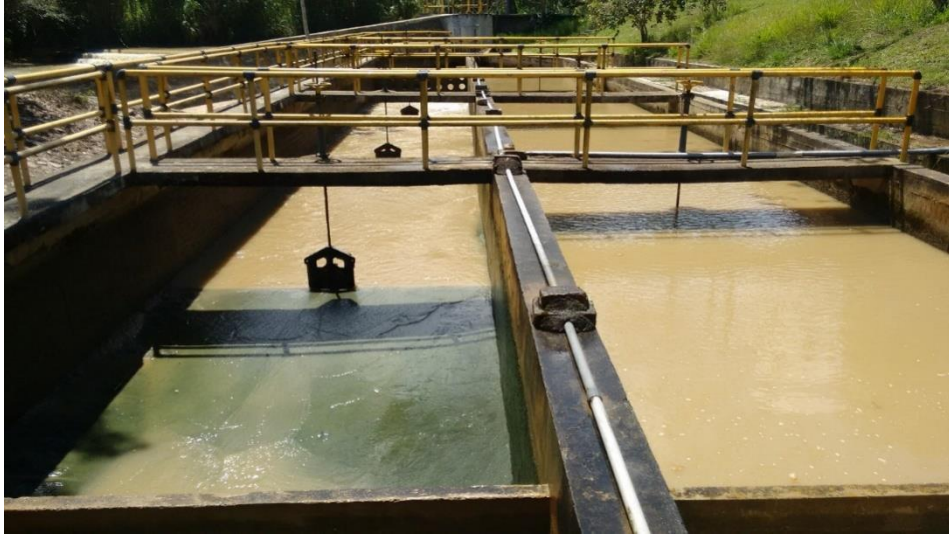
Panorámica 9 Tanques después del mantenimiento, ESPO S.A.
