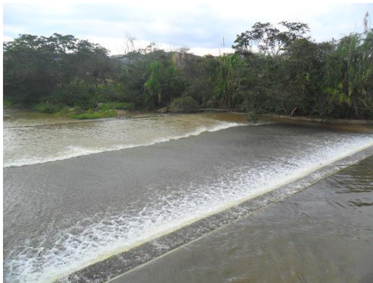
Figura 16. Fase de captación –PTAP El Algodonal.
