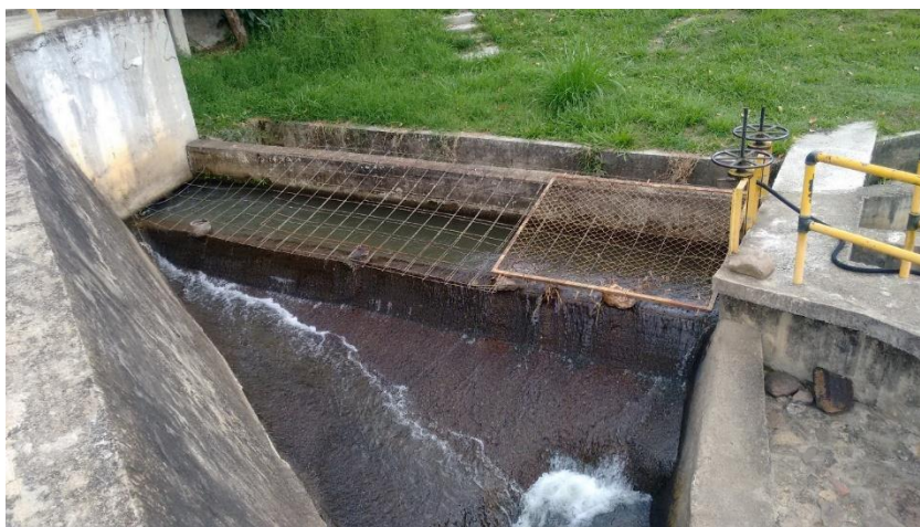
Figura 19. Panorámica 1 estructura canal de aducción PTAP-El Algodonal.
