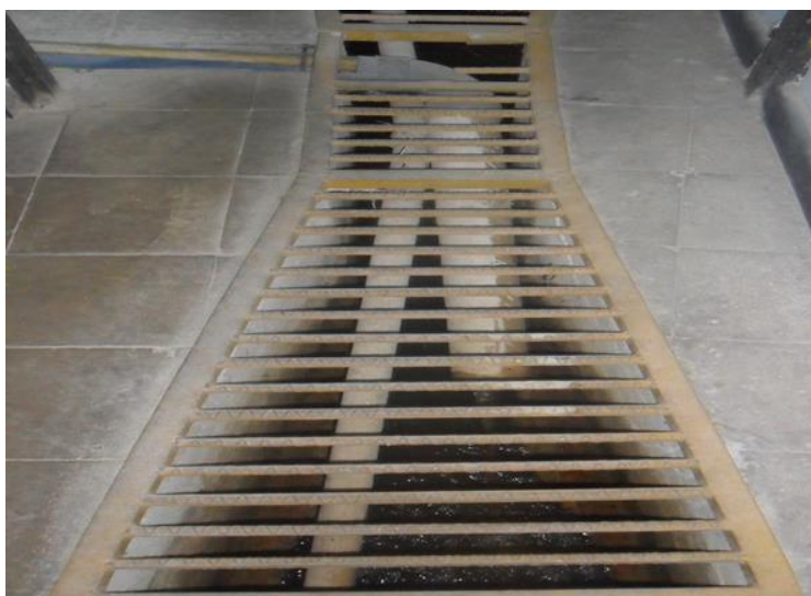
Figura 32. Panorámica 2 proceso coagulación (mezcla rápida) PTAP El Algodonal.
