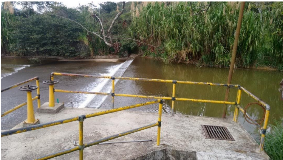
Canal de derivación, ESPO S.A.
