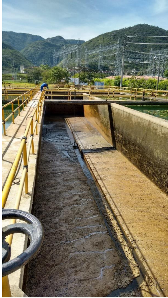
Panorámica 6 Operario realizando mantenimiento desde la parte superior, ESPO S.A. Fuente: Toma fotográfica, Sánchez Pérez, WesllyDonay. Estudiante Tecnología Obras Civiles, UFPS Ocaña. (2017).
