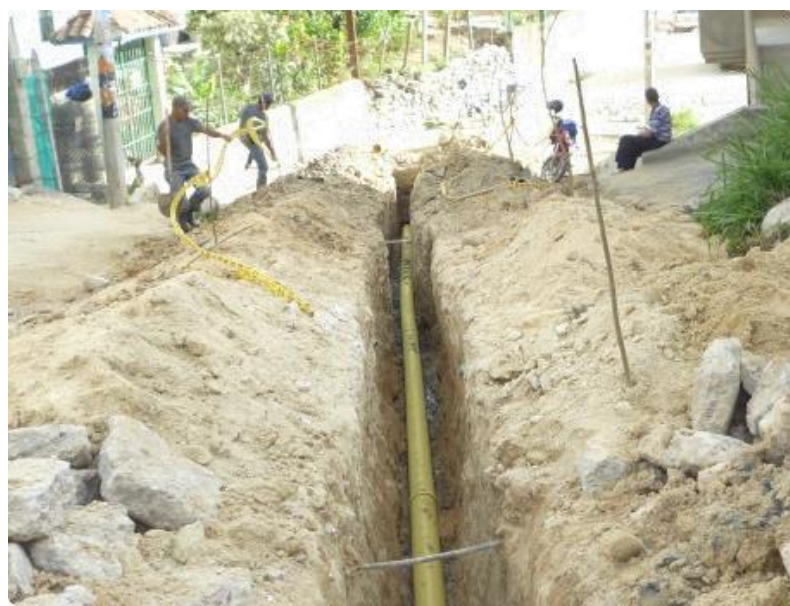
Figura 6. Trabajados de adecuación red de alcantarillado, ESPO S.A.
