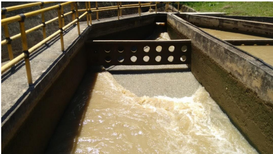
Panorámica 12 Apertura de compuerta, ESPO S.A.
