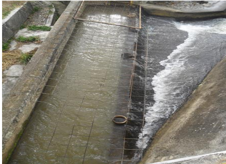
Figura 20. Panorámica 2 estructura canal de aducción PTAP-El Algodonal.
