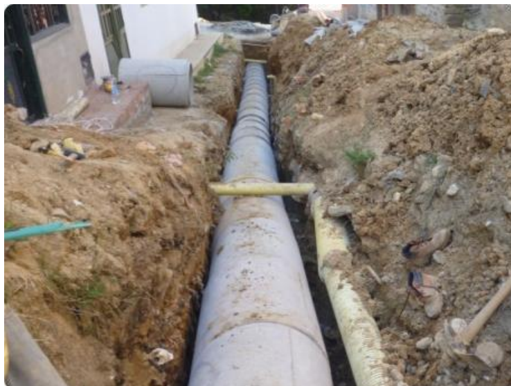
Figura 5. Tubería de alcantarillado, ESPO SA.
