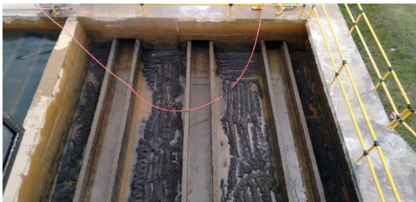
Figura 39. Panorámica 2 filtros PTAP El Algodonal.
