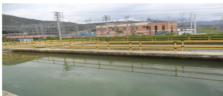
Figura 36. Panorámica 1 sedimentadores PTAP El Algodonal.
