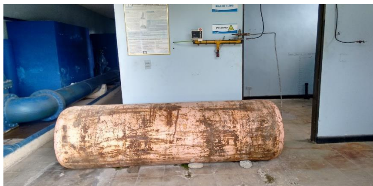
Figura 40. Panorámica 1 cilindro de cloración PTAP El Algodonal.
