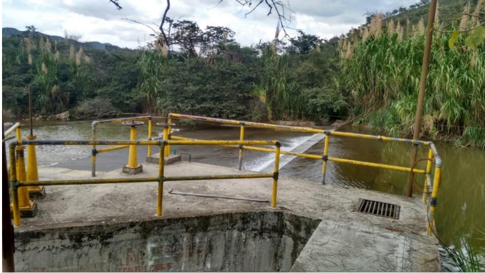
Panorámica canal de derivación, ESPO S.A.
