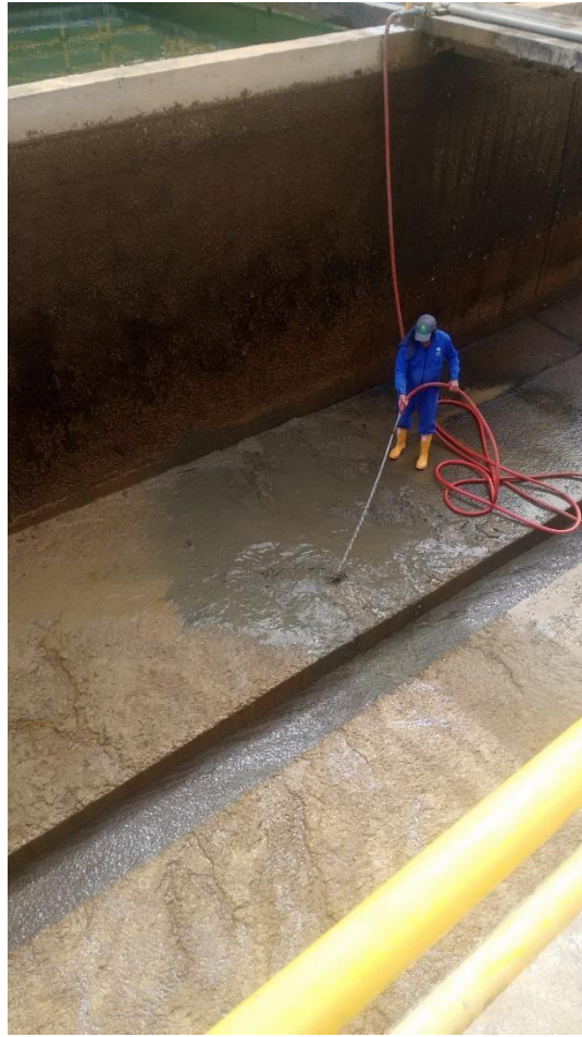
Panorámica 9 Operario dentro del Tanque sedimentador realizando lavado, ESPO S.A.
