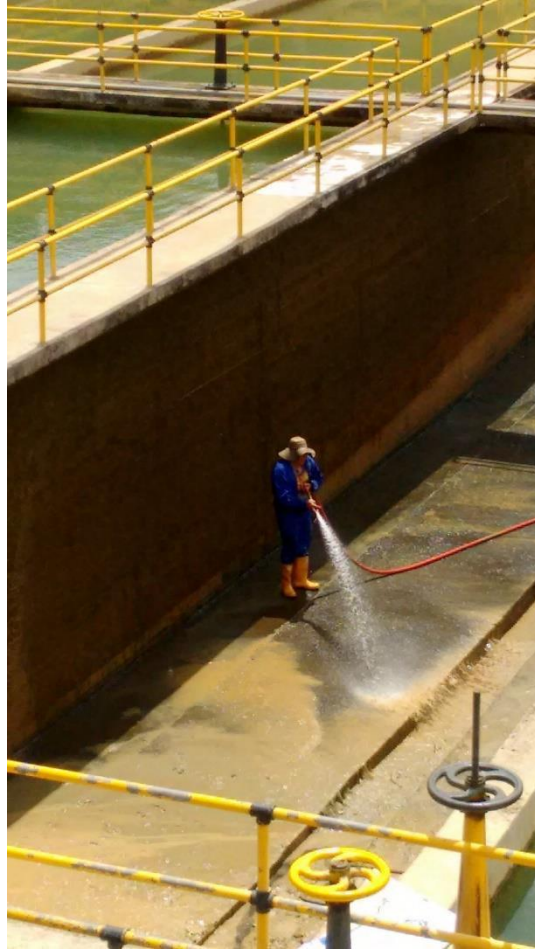
Panorámica 8 Operario dentro del Tanque sedimentador realizando lavado, ESPO S.A.
