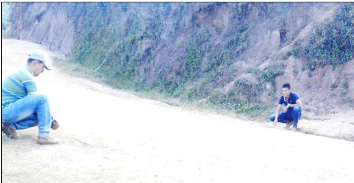
Figura 11. Labor técnica, determinando dimensiones de la vía.
