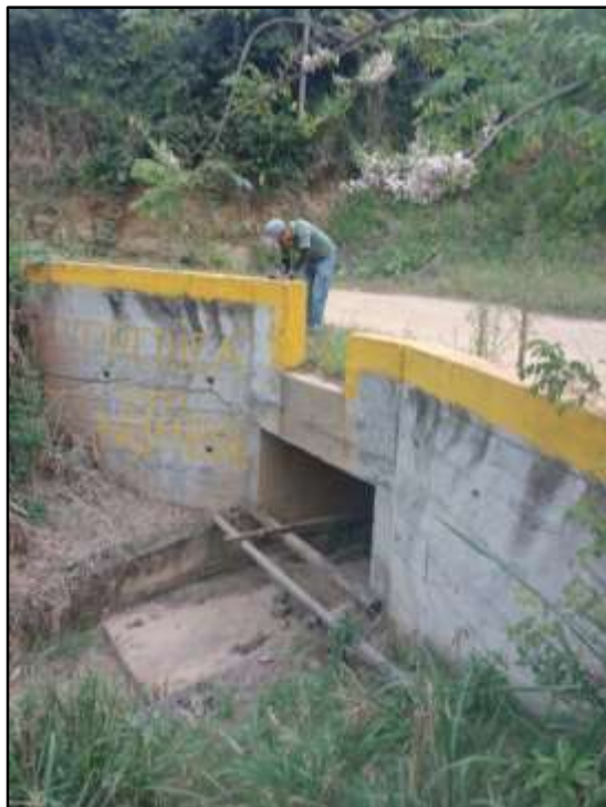
Figura 11 Visita ocular obras hidráulicas de la vía a intervenir.
