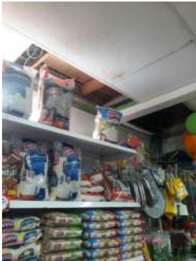
Foto 2. Cableado eléctrico en mal estado
