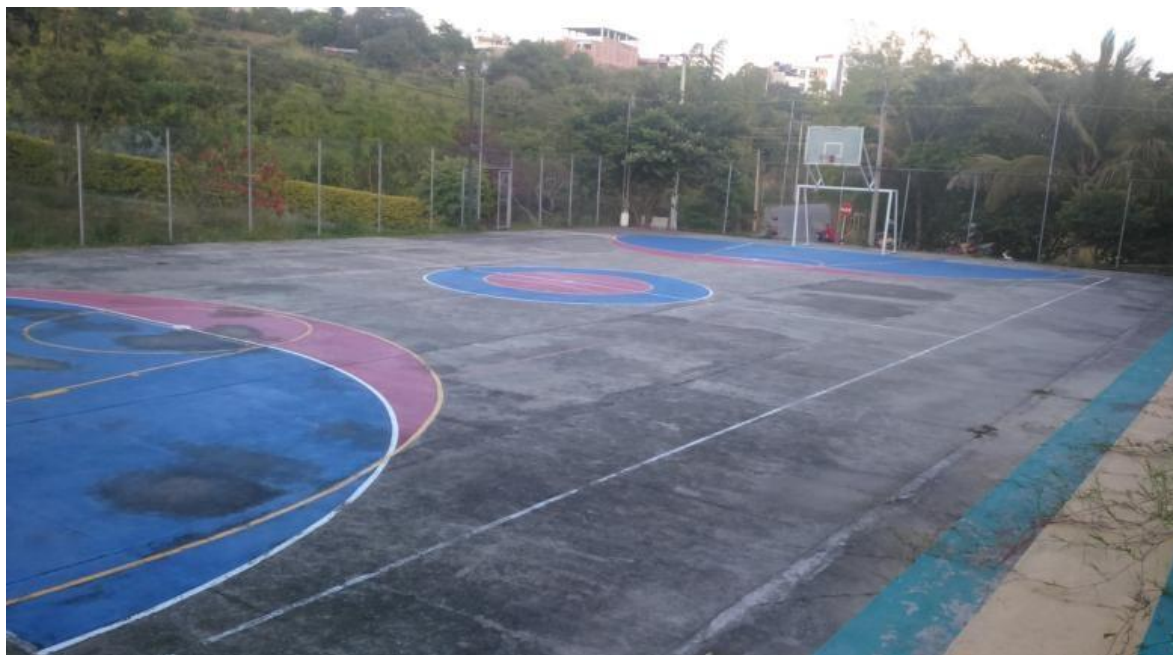
Apéndice D. Panorámica cancha múltiple, Condominio Campestre Torres del Cable.
