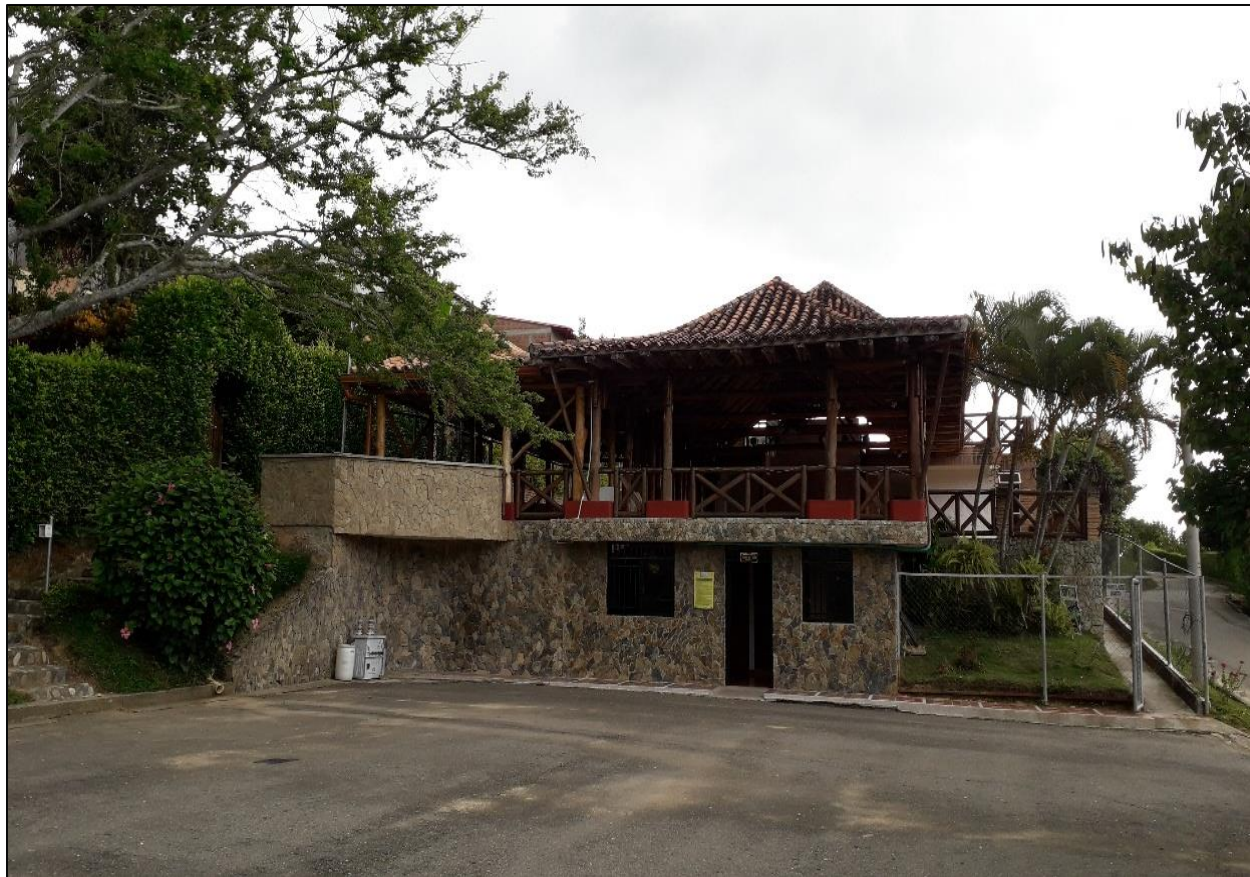
Figura 1. Oficina del área administrativa
