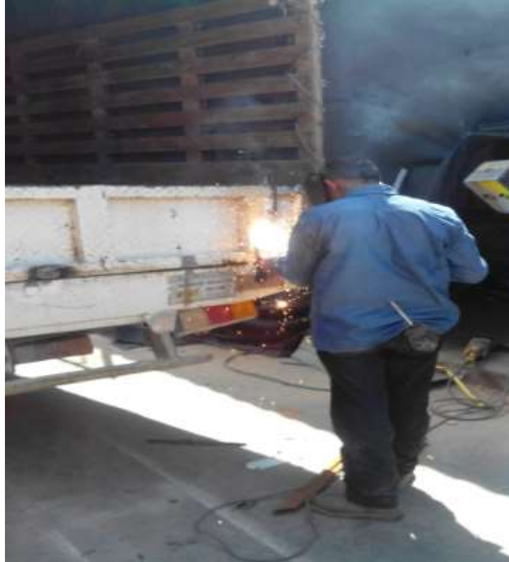
Foto 8. Reparación en Vehículo de Transporte.
