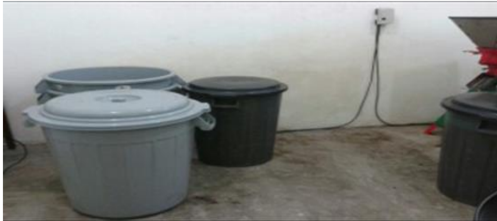
Figura 3. Tanques de almacenamiento
