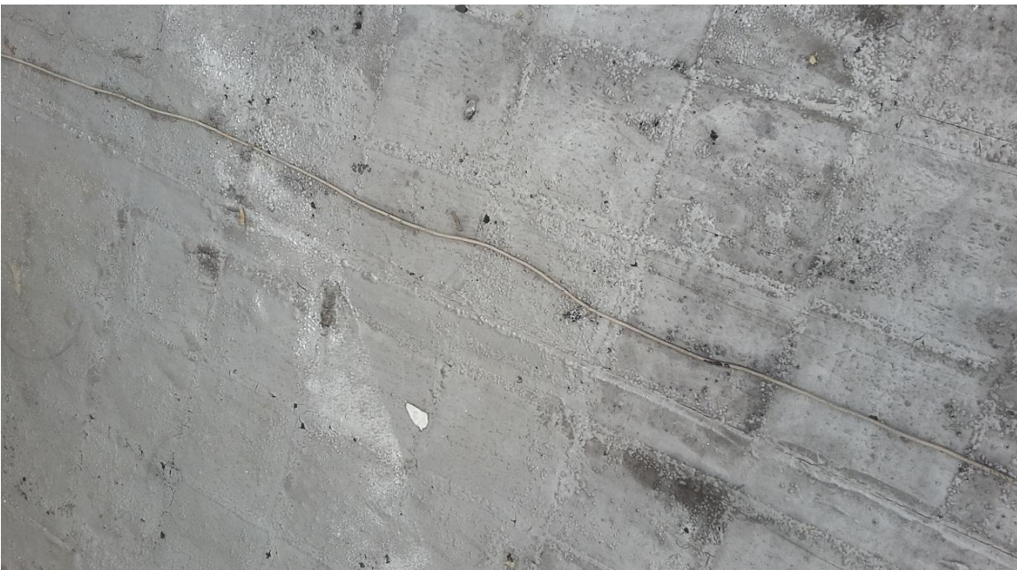
Figura 7. Tipo de cableado utilizado para el transporte de datos e internet
