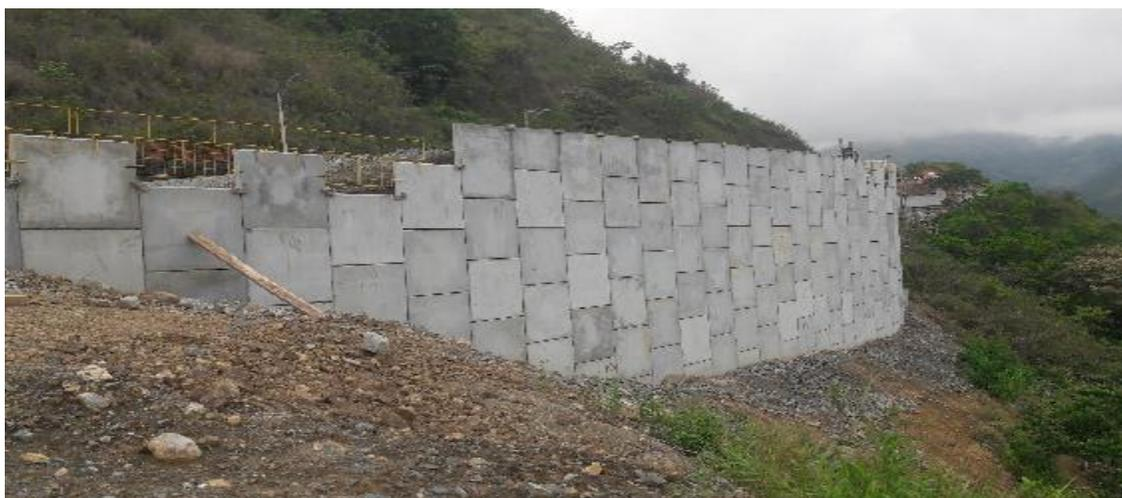
Figura 25 Vista parcial del montaje de losas de coronación
