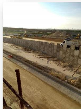
Figura 20 Relleno en muro de acceso a estribo 2 del Puente Pumarejo, Barranquilla, Colombia
