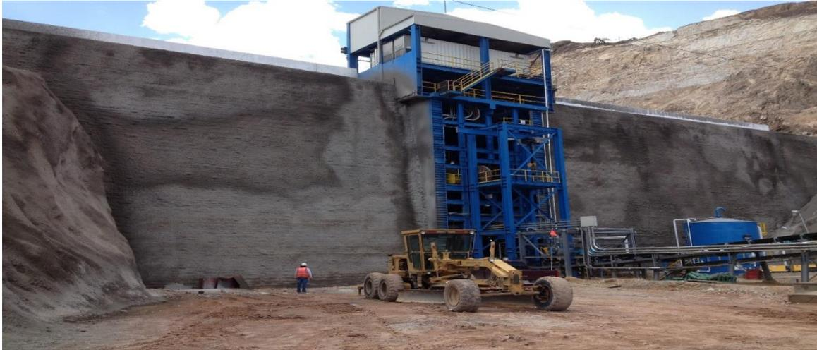
Figura 13 Muros de contención mediante geosintéticos
