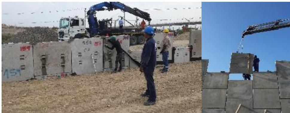
Figura 24 Colocación y montaje de losas de coronación
