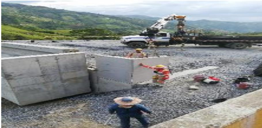
Figura 23 Colocando losas de esquina.
