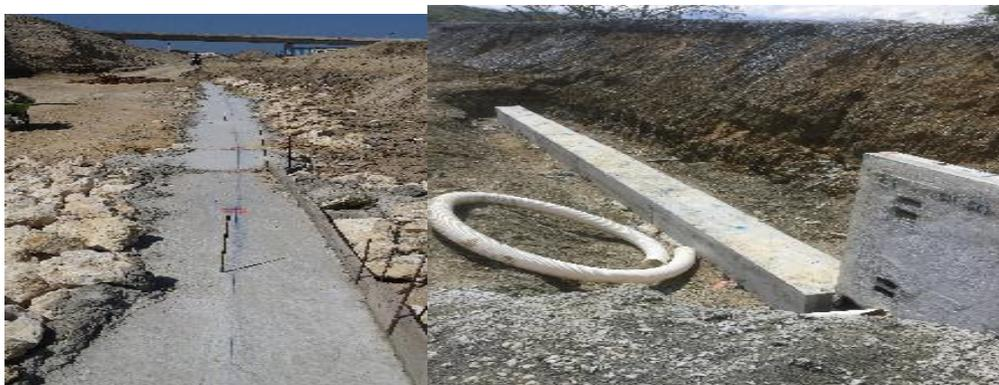
Figura 17 Construcción de vigas de nivelación y filtros
