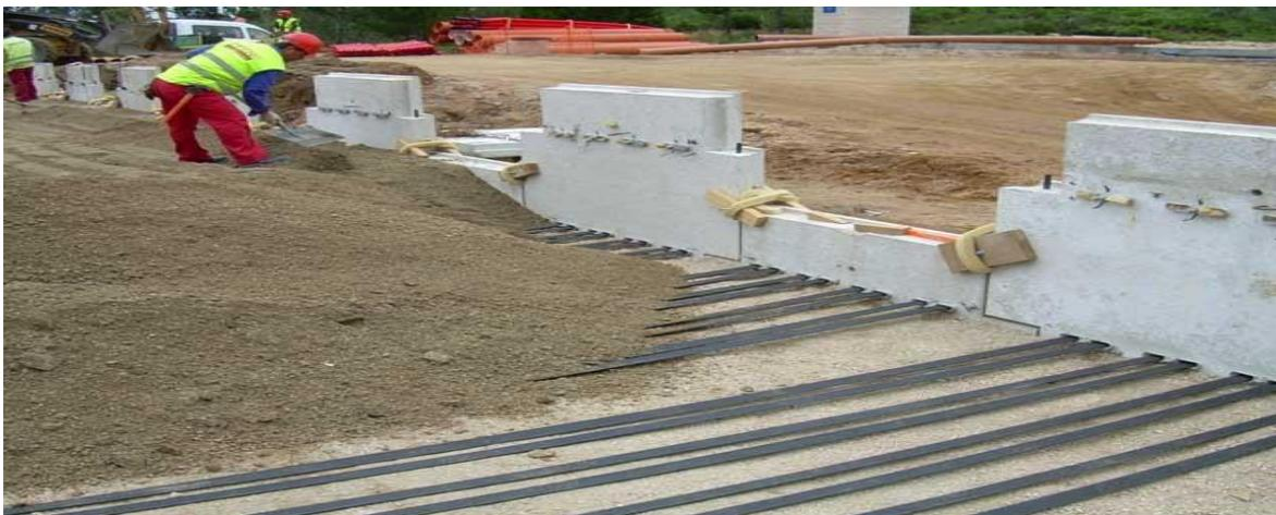
Figura 3 Detalle de las bandas y la placa de un muro de Tierra Armada
