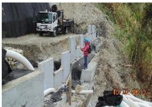
En construcción de vigas y nivelación de filtros, hay que tener en cuenta que de acuerdo con los diseños estructurales que se establezcan para el muro que se aspira a levantar, dependen la flexibilidad y funcionamiento satisfactorio del muro mecánicamente estabilizado como tal.
