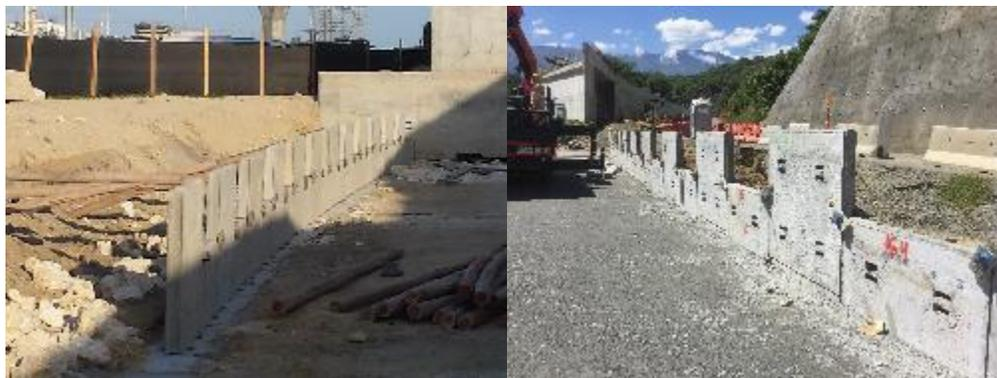
Figura 18 Instalación de losas de arranque y bandas de estabilización de losas
