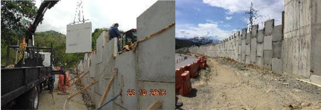
Figura 22 Colocación y montaje de losas estándar.
