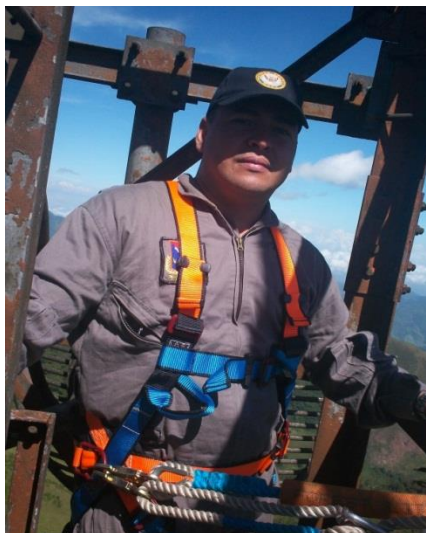
Figura 6. Inspección torres de telecomunicaciones
