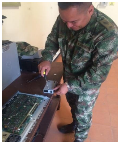
Figura 3. Mantenimiento Router y Switch
