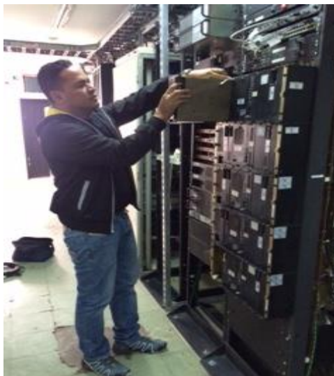
Figura 5. Mantenimiento repetidoras Quantar Motorola
