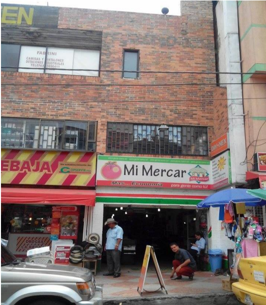
Imagen K: Toma de la Altura del Edificio Rebaja Droguería mercado.
