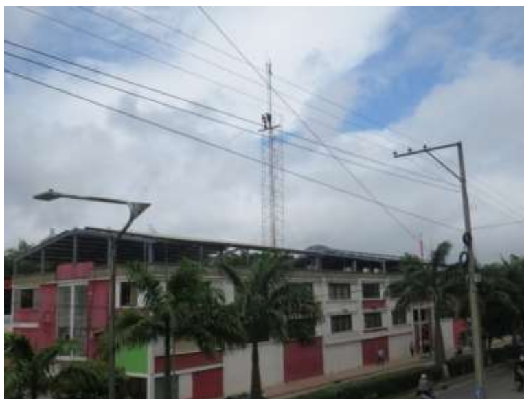
Figura 8. Torre sede la primavera de la UFPSO
