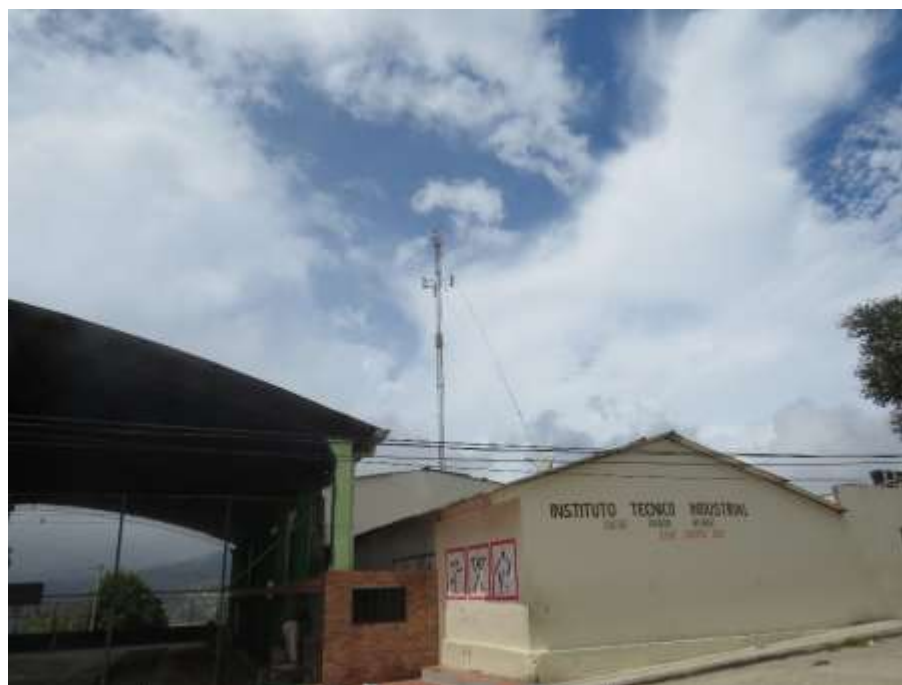
Figura 12. Torre Instituto Técnico Industrial LUCIO PABON NUÑEZ sede cristo rey.
