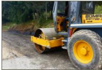
Curado y Compactado.
