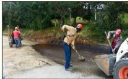
Riego de Agregado.
