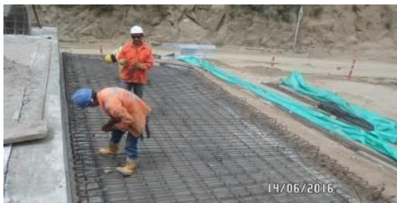
Fotografía 49. Armado Acero de Refuerzo Losas de Aproximación Acceso al Puente
