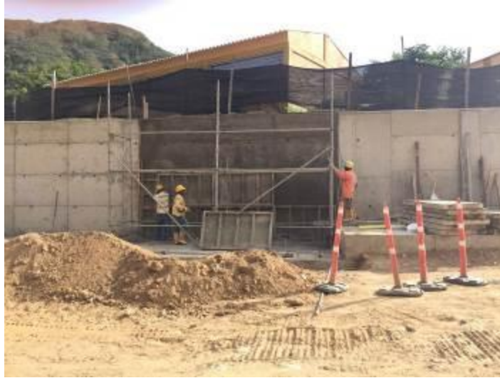
Fotografía 55. Construcción Último Módulo del Muro de Contención
