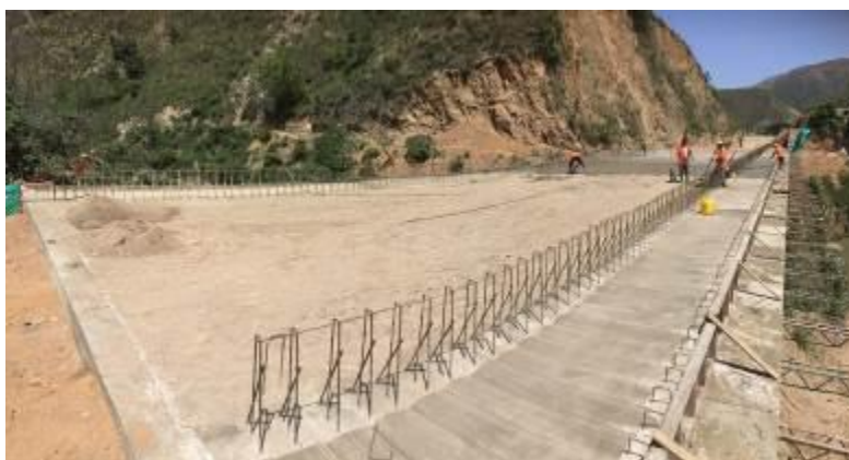
Fotografía 45. Fundida del Tablero o Placa del Puente
