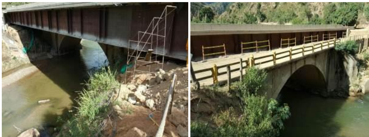
Fotografía 23. Mitad de la Estructura del puente antiguo sin demoler
