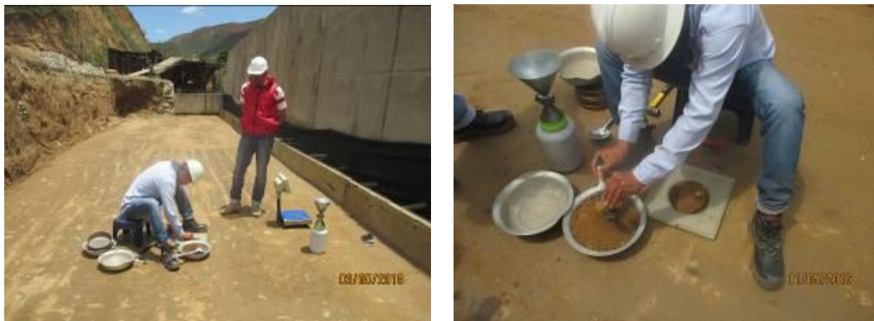
Fotografía 34. Ensayo de densidades en campo – Método Cono de Arena
