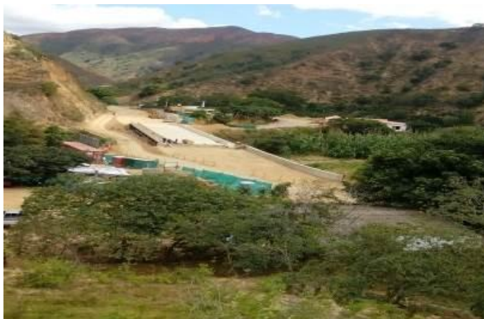
Fotografía 61. Panorámica del Estado del Puente a la fecha de terminación de la Pasantía
