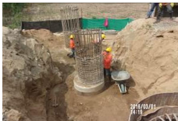
Fotografía 12. Instalación de camisas permanentes y fundidas de pilotes Nos. 5, 6 y 7 salida del puente
