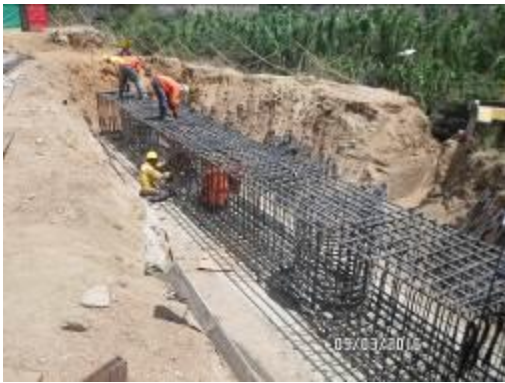
Fotografía 21. Pilotes 1 al 6 ya fundidos e inicia la colocación del acero de refuerzo para las vigas cabezales
