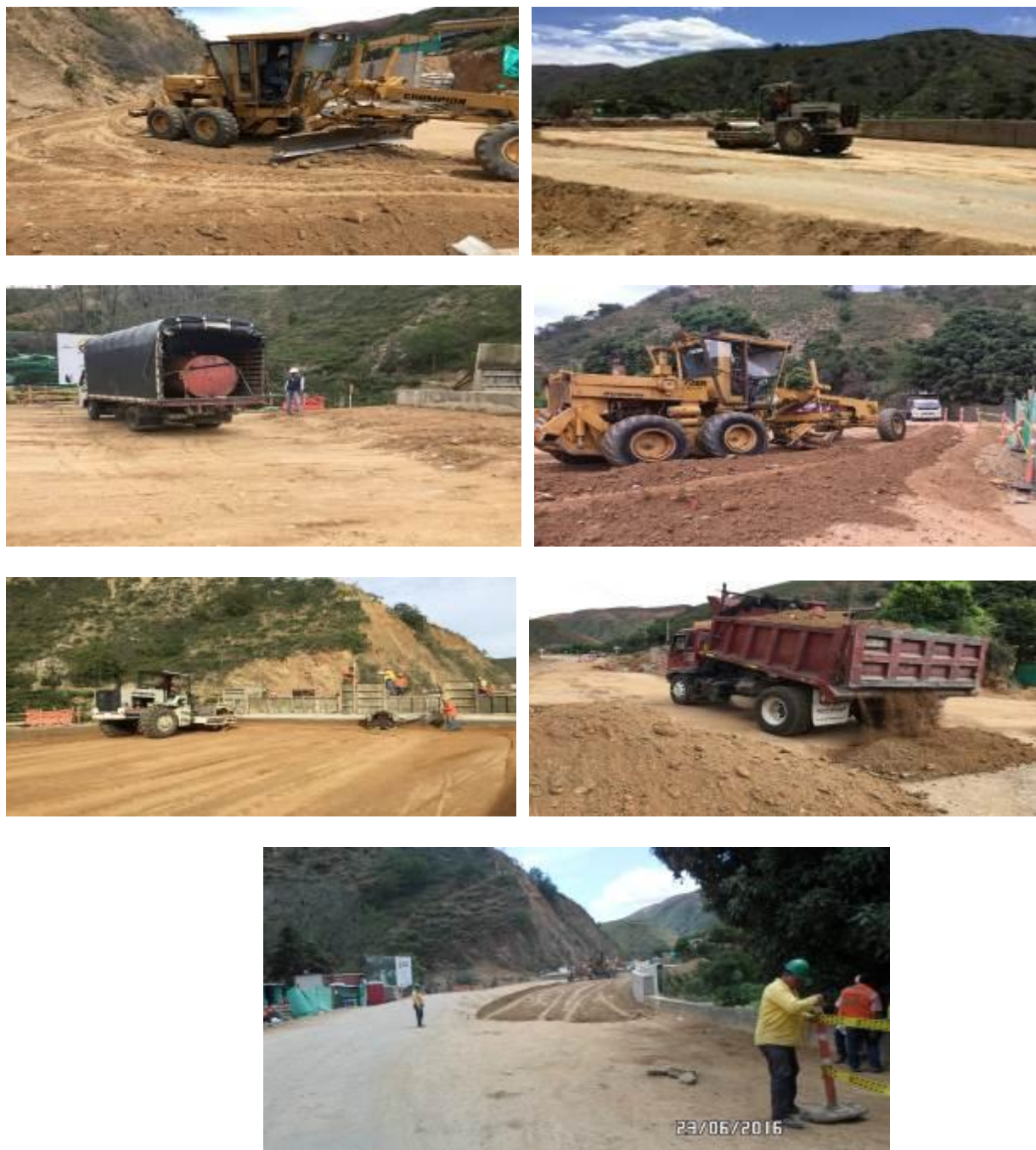
Fotografía 51. Terraplenes Acceso y Salida al Puente
