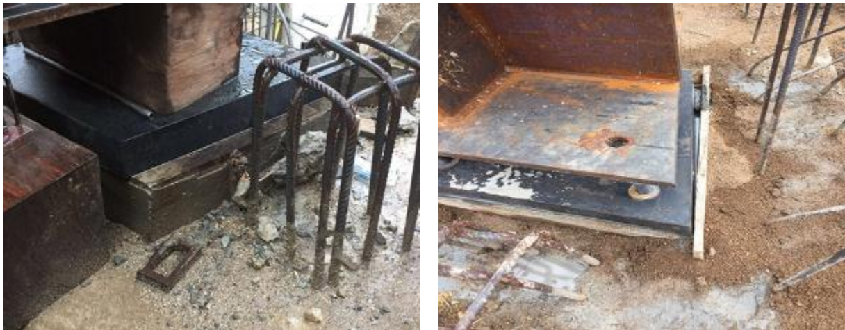
Fotografía 26. Apoyo Elastomérico 700x700x100 mm -GRADO 60
