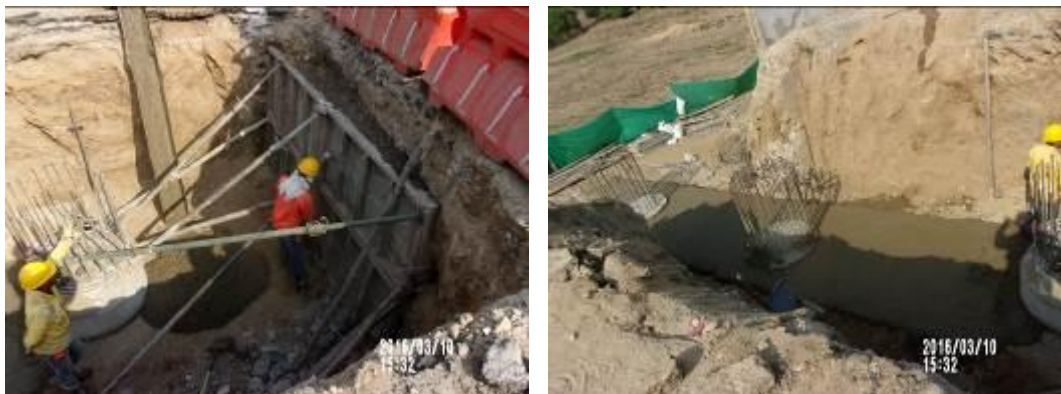
Fotografía 14. Solado viga cabezal salida del puente – Estribo sur
