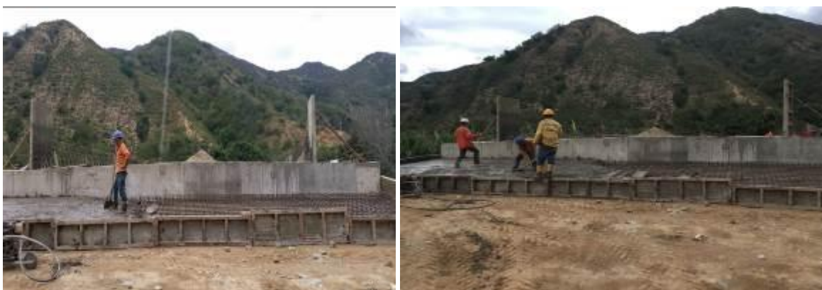
Fotografía 50. Fundida Losa de Aproximación acceso del puente
