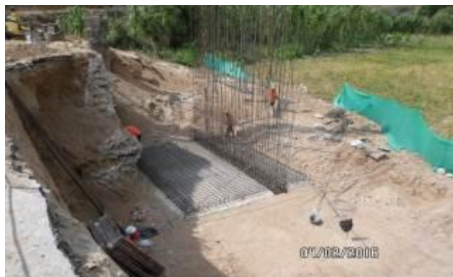
Fotografía 8. Construcción Muro en concreto reforzado - Módulos 2 y 3
