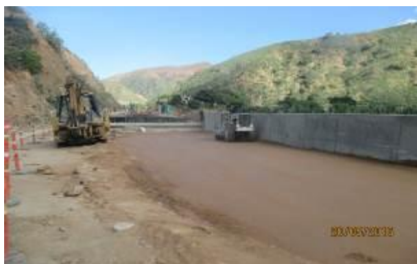
Fotografía 33. Relleno del Muro en Concreto Reforzado Costado Oriental
