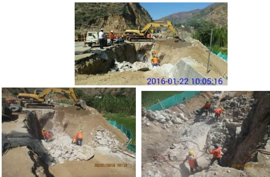
Fotografía 7. Demolición muro de contención existente en concreto en el lado oriental salida del puente
