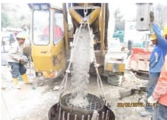
Fotografía 12. Instalación de camisas permanentes y fundidas de pilotes Nos. 5, 6 y 7 salida del puente
