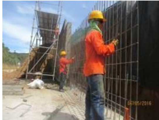
Fotografía 53. Armado del Acero de Refuerzo - Muro de Contención Colegio El Tarrita
