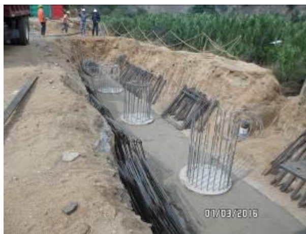
Fotografía 13. Excavación, Instalada de camisas, Acero de refuerzo y Fundida de pilotes Nos. 1, 2 y 3 acceso al puente
