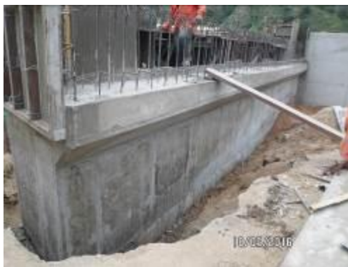
Fotografía 42. Muro Espaldar y Ménsula ya fundida Salida del Puente
