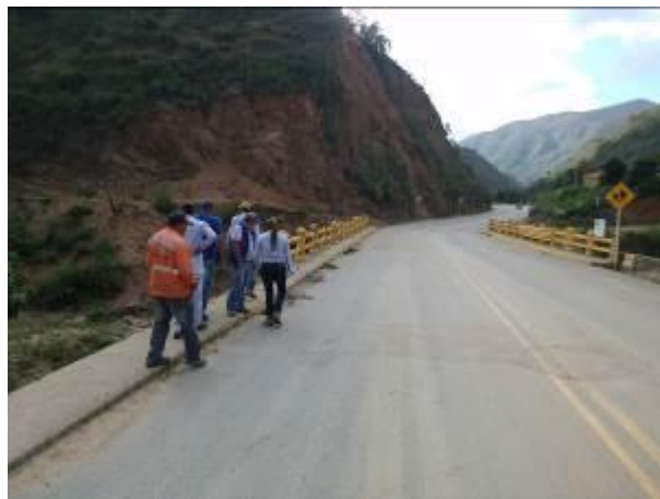
Fotografía 4. Visita inicial de obra
