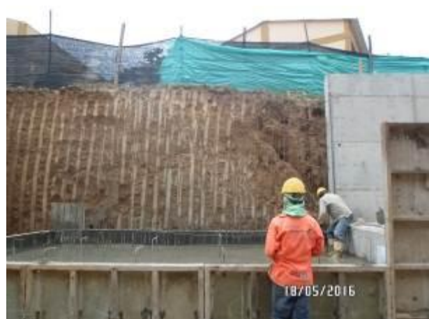
Fotografía 54. Fundida de los módulos 5, 6 y 7 del Muro de Contención Colegio El Tarrita
