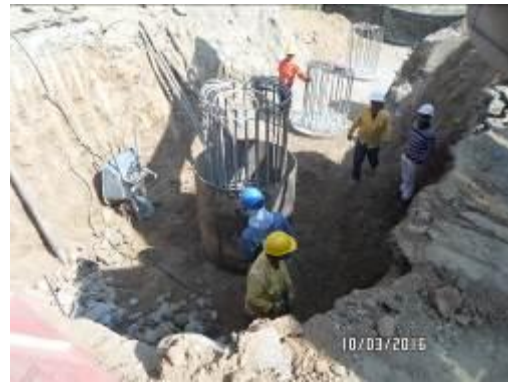
Fotografía 21. Pilotes 1 al 6 ya fundidos e inicia la colocación del acero de refuerzo para las vigas cabezales
