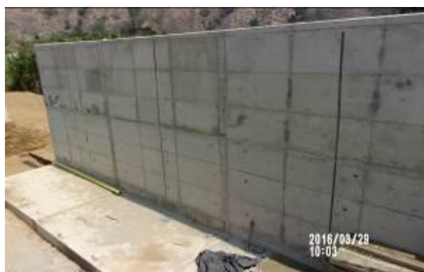
Fotografía 28. Módulos Nos. 2, 3, y 4 fundidos
