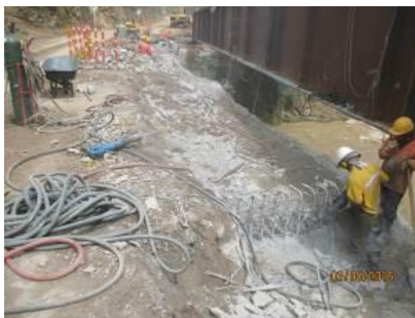
Fotografía 22. Demolición Puesto Existente - Costado Oriental – Primera parte
