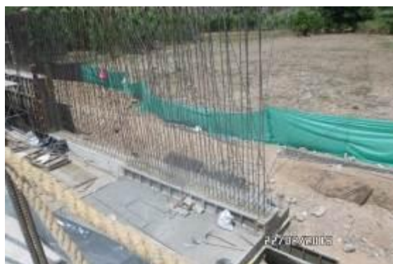
Fotografía 9. Zarpa Muro en concreto reforzado - Módulos 4 y 5
