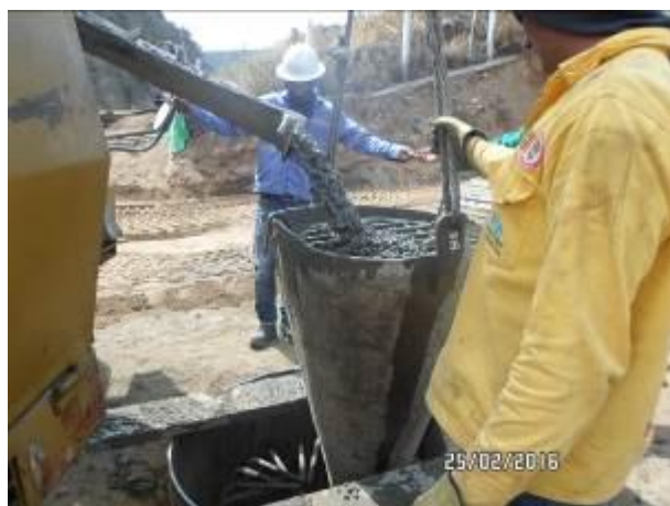
Fotografía 13. Excavación, Instalada de camisas, Acero de refuerzo y Fundida de pilotes Nos. 1, 2 y 3 acceso al puente
