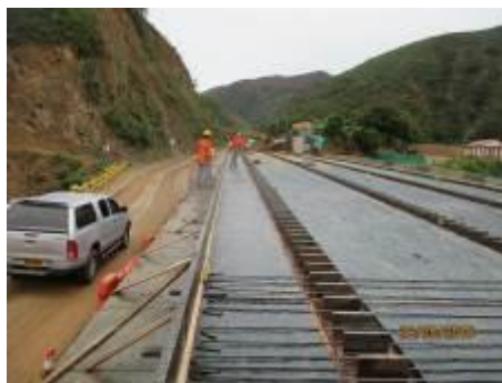
Fotografía 43. Formaleta para la placa del puente
