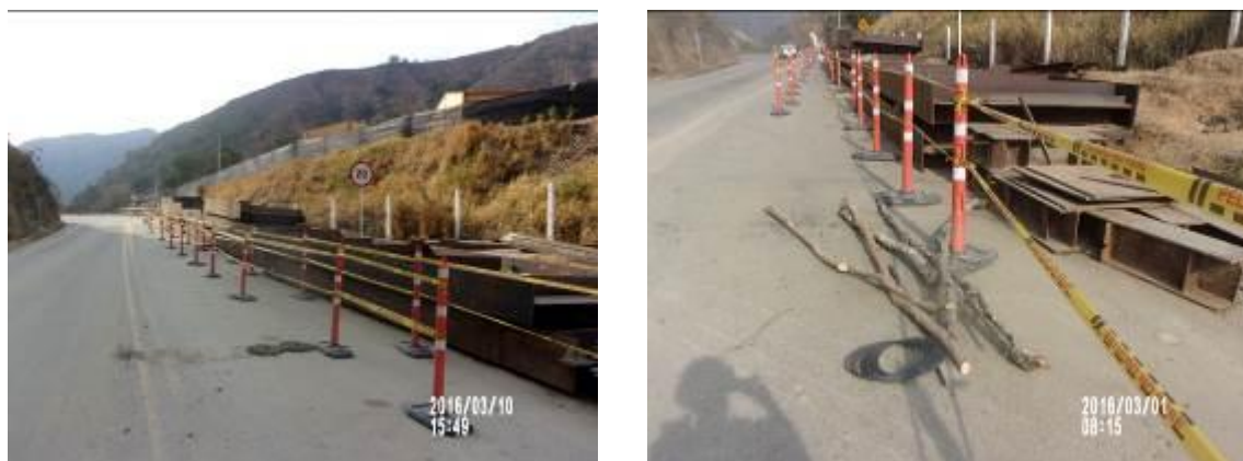
Fotografía 15. Elementos metálicos de la estructura del puente en la obra
