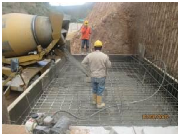
Fotografía 54. Fundida de los módulos 5, 6 y 7 del Muro de Contención Colegio El Tarrita
