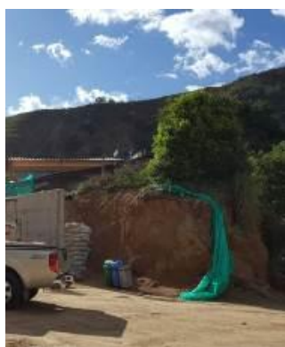
Fotografía 62. Talud lado Sur del Colegio El Tarrita sin ninguna protección
