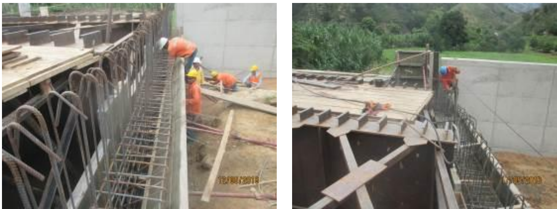
Fotografía 41. Acero de Refuerzo Muro Espaldar y Ménsula Salida del Puente
