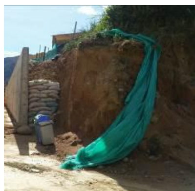
Fotografía 62. Talud lado Sur del Colegio El Tarrita sin ninguna protección
