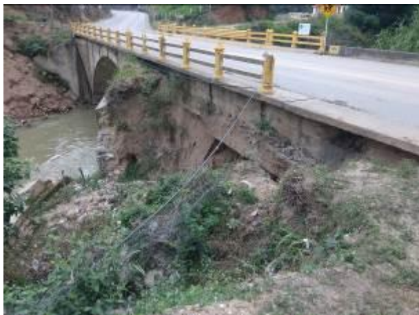
Fotografía 3. Estado inicial del puente
