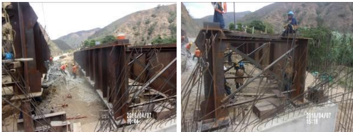
Fotografía 24. Vigas Metálicas Nos. 1 y 2 armadas e instaladas sobre las vigas cabezales
