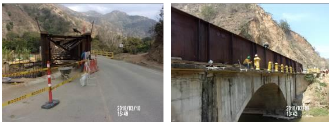
Fotografía 16. Armada de la Estructura Metálica
