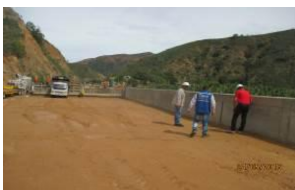
Fotografía 33. Relleno del Muro en Concreto Reforzado Costado Oriental
