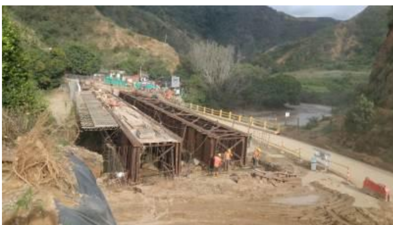
Fotografía 25. Vigas Metálicas Nos. 3 y 4 Armadas e Instaladas sobre las Vigas Cabezales
