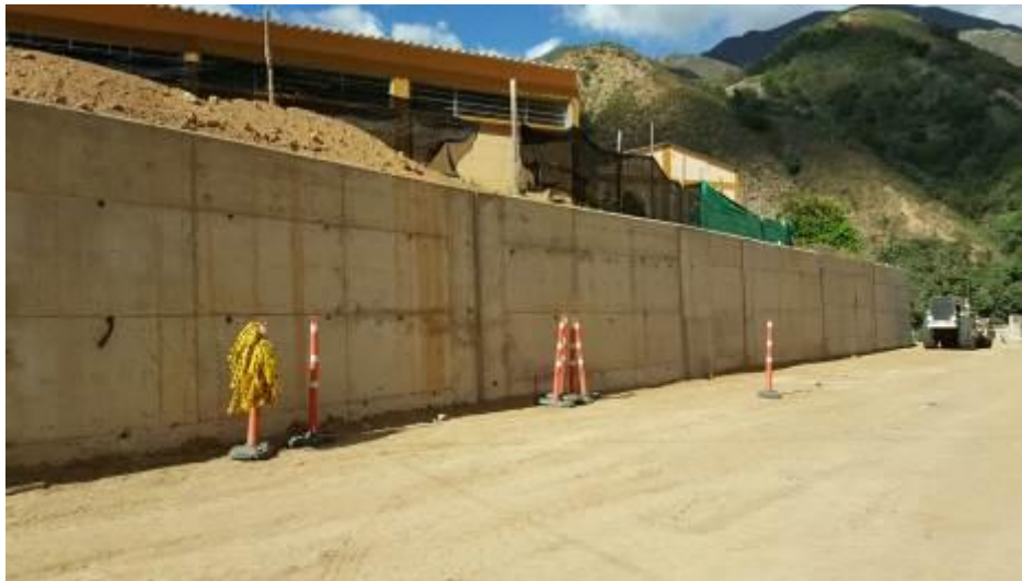
Fotografía 56. Vista General del Muro en Concreto Reforzado Terminado
