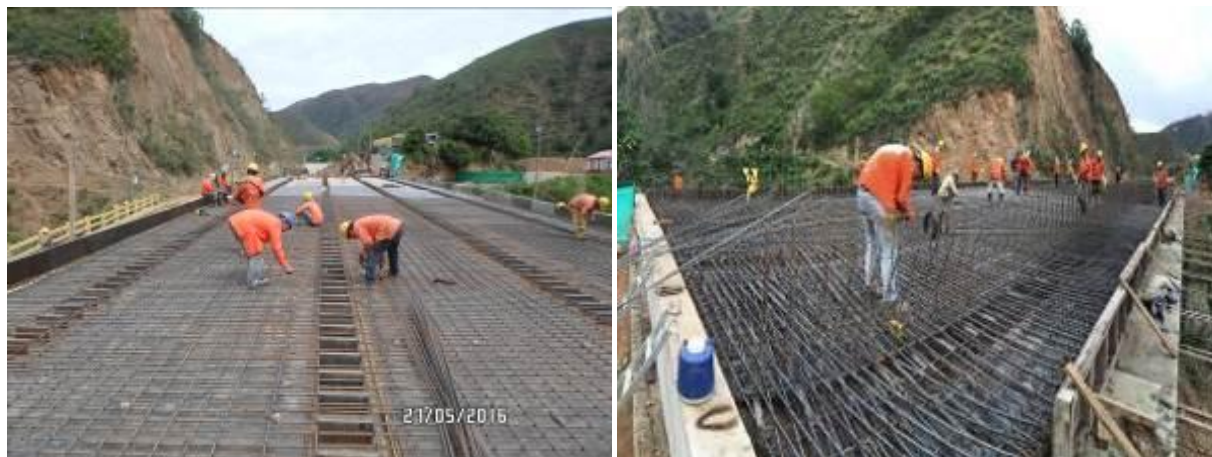
Fotografía 44. Armado Acero de Refuerzo
