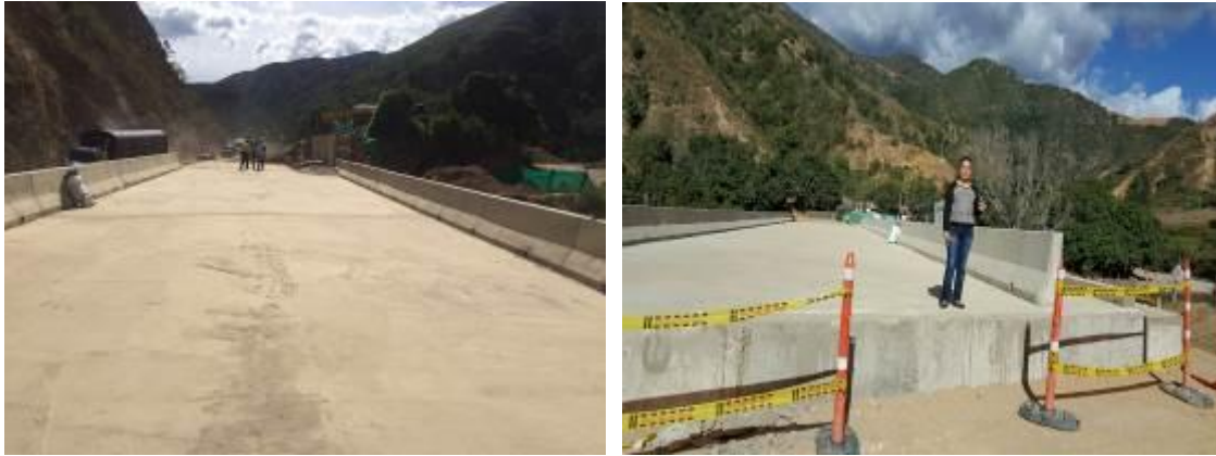
Fotografía 46. Vista general del Tablero o Placa del puente ya fundida
