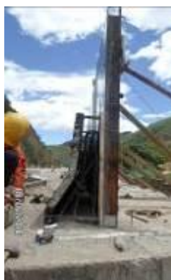
Fotografía 59. Formaleta y New Jersey fundido
