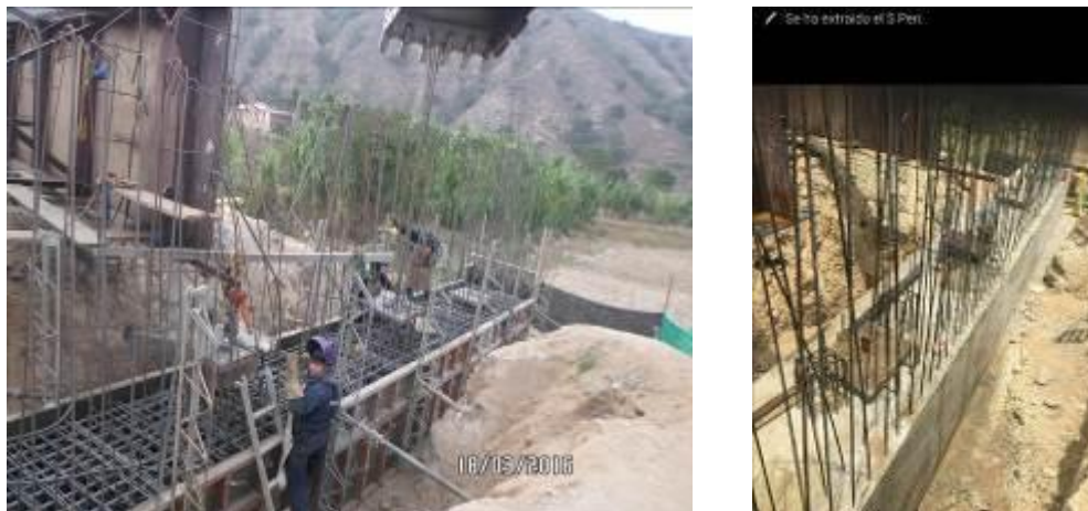
Fotografía 38. Fundida Viga Cabezal Salida del Puente
