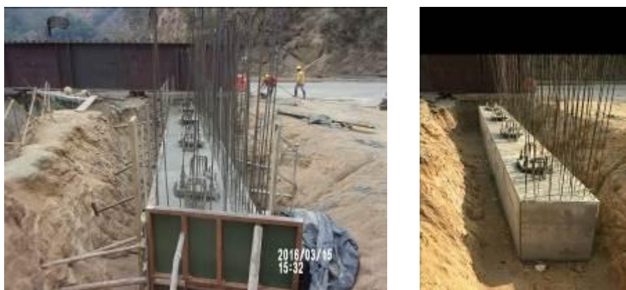
Fotografía 36. Viga Cabezal Acceso al Puente ya fundida
