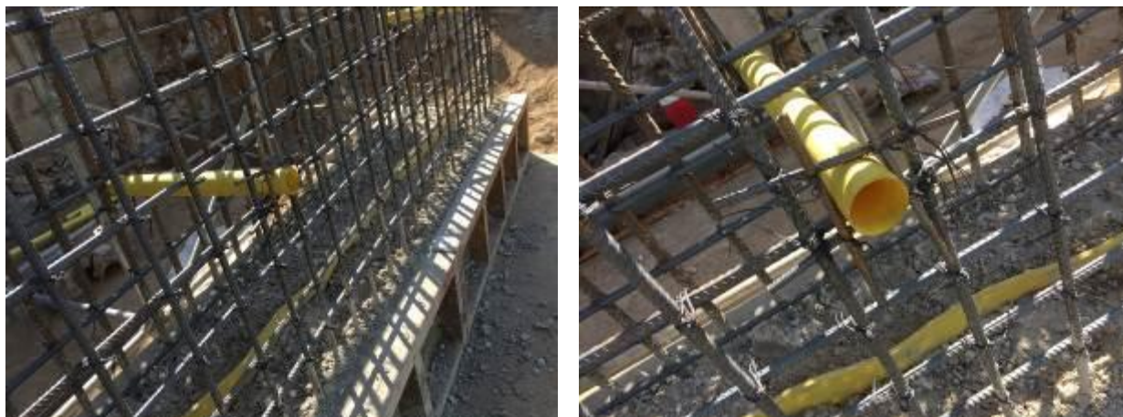
Fotografía 27, Instalación de lloraderos del muro de contención
