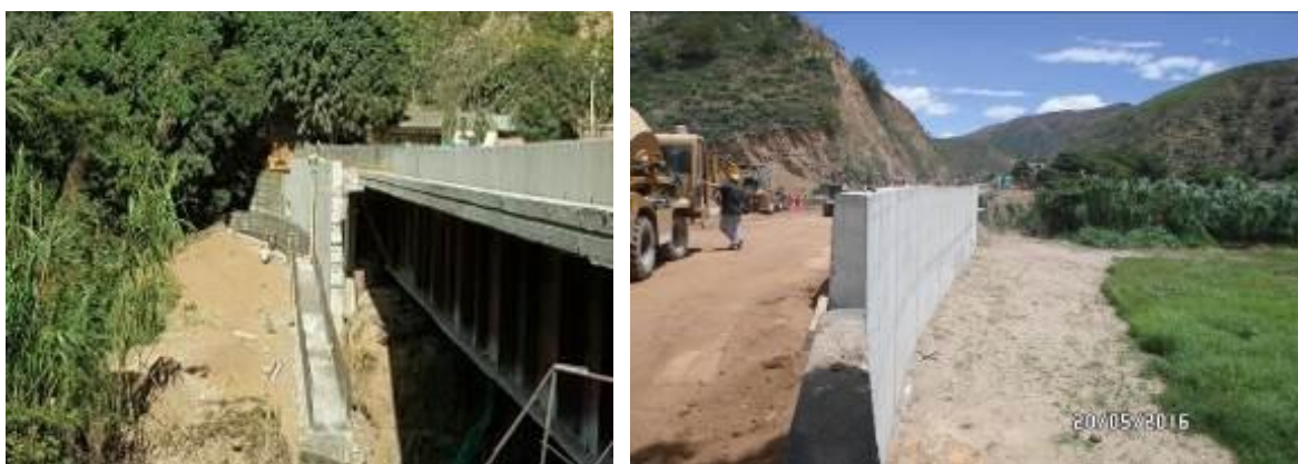
Fotografía 31. Espaldar del Muro de Contención Costado Oriental Salida del Puente ya Construido
