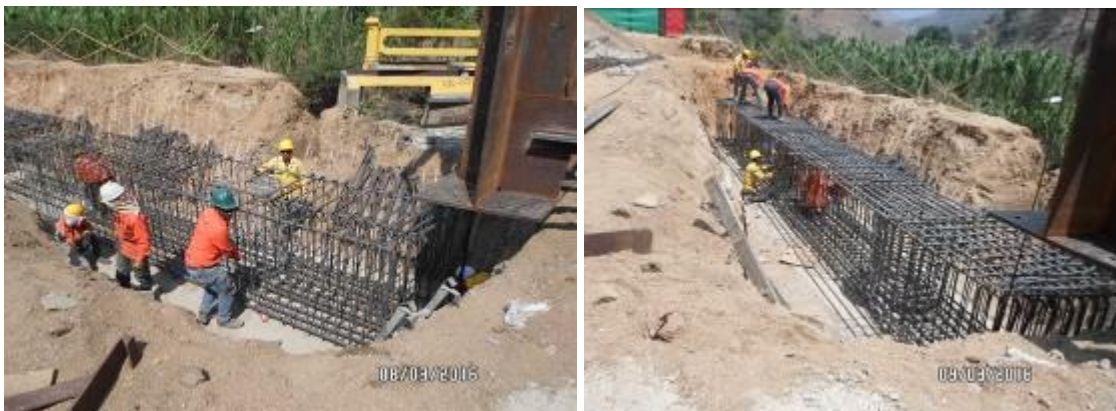
Fotografía 35. Acero de refuerzo Viga Cabezal Acceso al Puente
