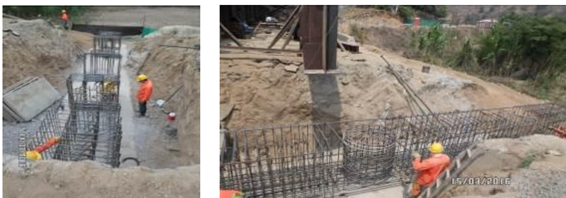
Fotografía 37. Acero de Refuerzo Viga Cabezal Salida del Puente
