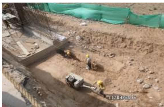
Fotografía 9. Zarpa Muro en concreto reforzado - Módulos 4 y 5
