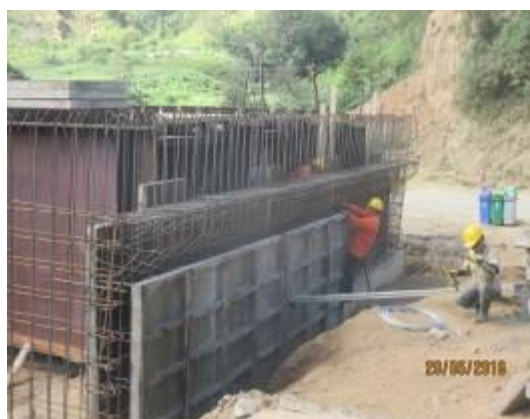
Fotografía 39. Acero de Refuerzo Muro Espaldar y Ménsula Entrada del Puente
