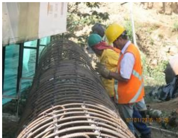
Fotografía 11. Armado acero de refuerzo pilotes
