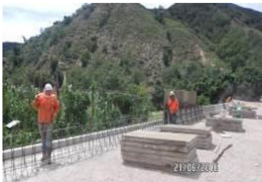
Fotografía 58. Acero de Refuerzo y fundida del New Jersey
