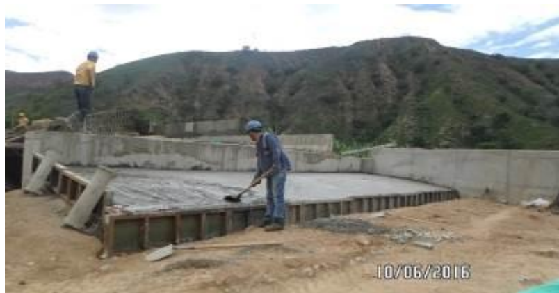
Fotografía 48. Losa de Aproximación Salida del Puente Fundida
