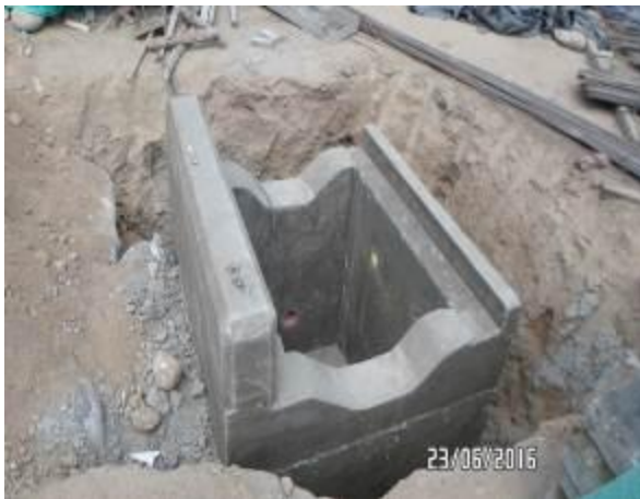
Fotografía 57. Construcción Obras de Drenaje – Alcantarillas
