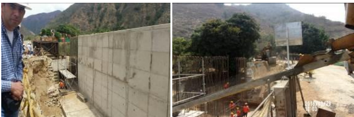
Fotografía 29. Armado de Acero de Refuerzo de los Módulos 1, 5, 6 y 7
