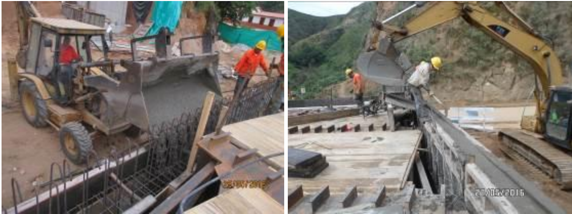
Fotografía 40. Fundida Muro Espaldar y Ménsula Entrada al Puente
