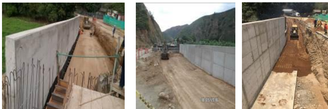
Fotografía 32. Muro de Contención Construido y se inician los rellenos
