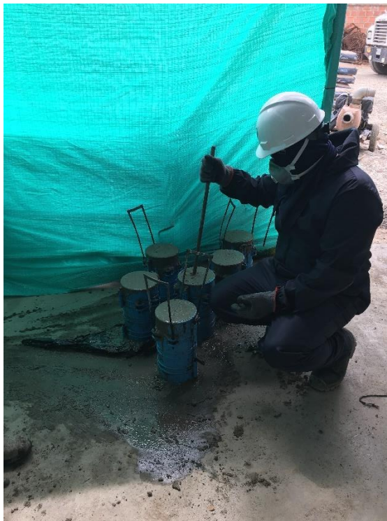
Figura 15 Elaboración de cilindros de concreto.
