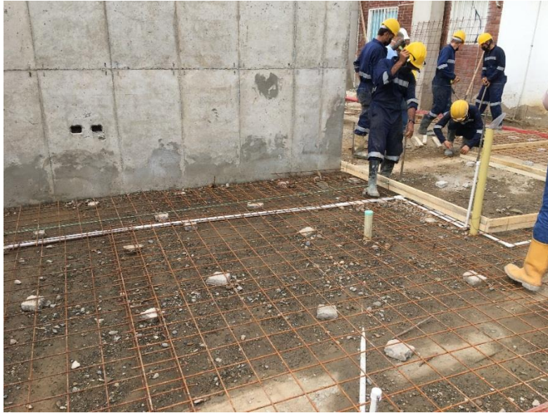
Figura 33 Preparación para fundir losa de contrapiso.
