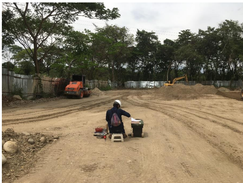
Figura 32 Obtención del porcentaje de compactación.
