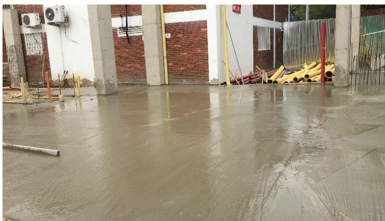
Figura 39 Terminación de fundida de placa aligerada.
