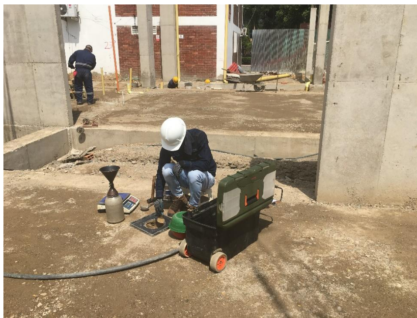
Figura 11 Toma de densidades a nivel de rasante
