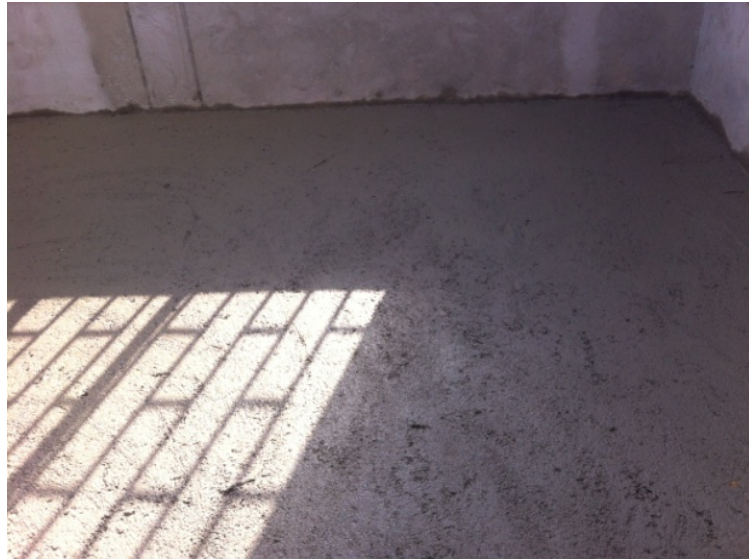
Foto 5. Piso en mortero simple exp.0.07M
