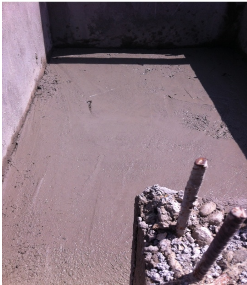
Foto 2. Piso en concreto simple exp. 0.10m
