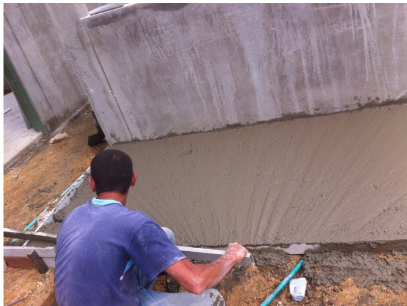
Foto 6. Anden perimetral en concreto exp. 0.10 M
