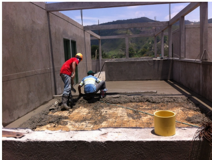
Foto 19. Extendida del concreto
