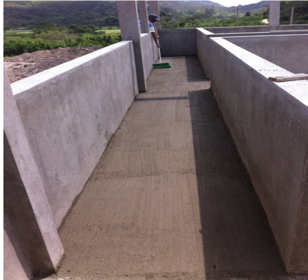
Foto 7. Anden perimetral en concreto exp. 0.10 M
