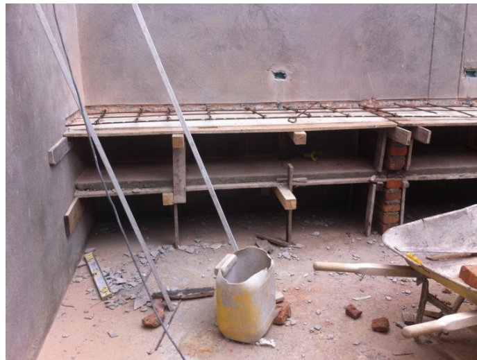
Foto 12 armada en acero del mesón del laboratorio
