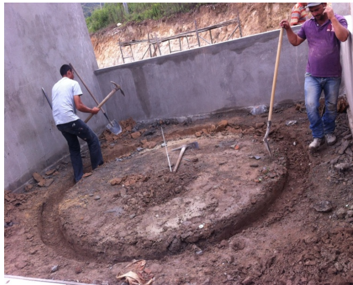
Foto 8. Localización y replanteo del corral de monta
