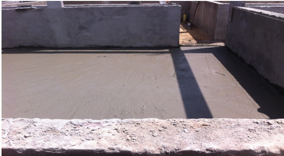
Foto 3. Piso en concreto simple exp. 0.10M
