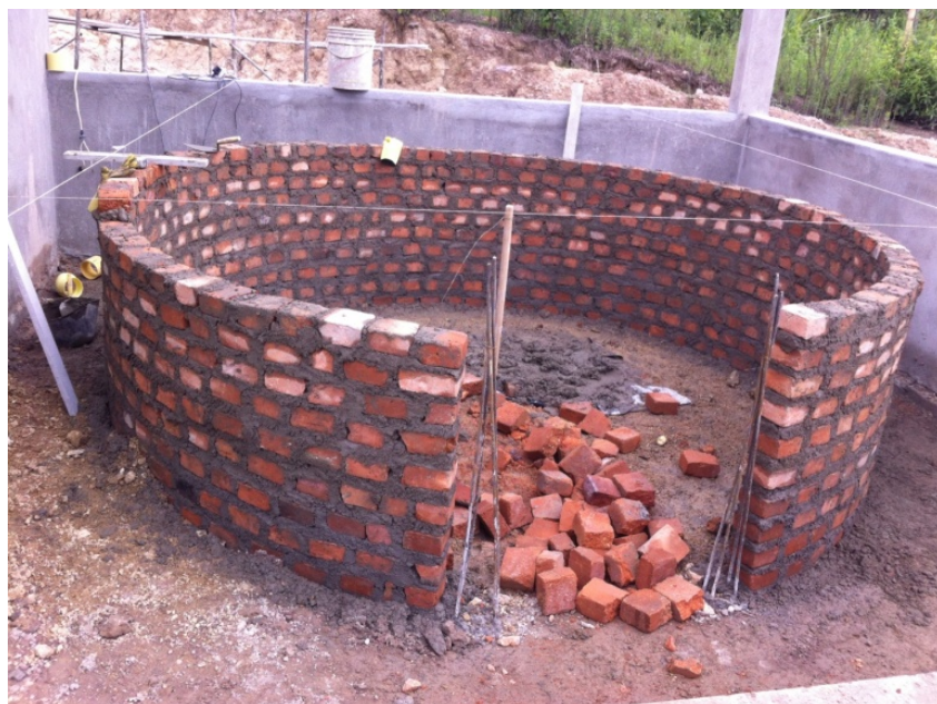
Foto 9. Pegue de ladrillos corral de monta.
