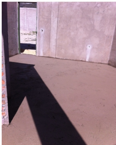
Foto 4. Piso en mortero simple exp.0.07M
