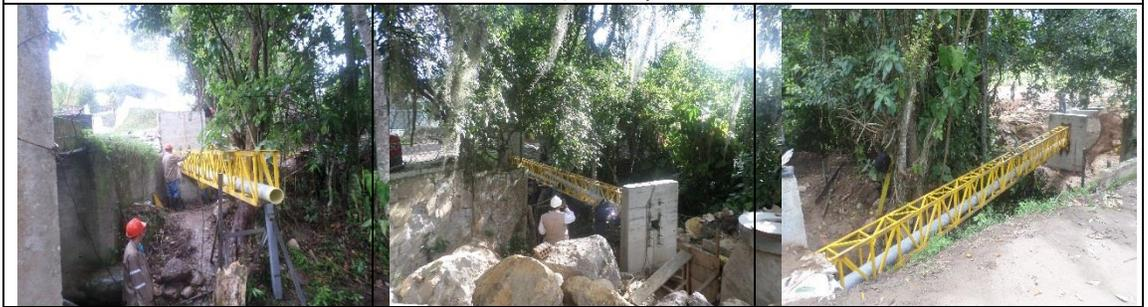
Paso Elevado L= 12 ml, tubería de 8"
