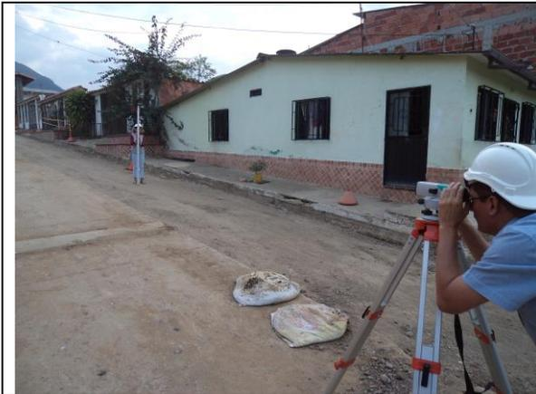
**Foto 19.** Verificación de Capa de base a través del análisis de cota cero Pozo 40-45
