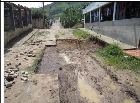
**Foto 15.** Demolicion Placa Huella
