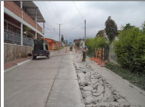
**Foto 13.** Demolicion de Pavimento Rigido
