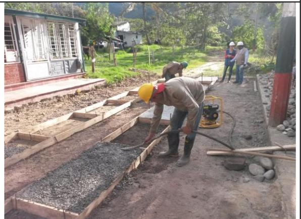
**Foto 22.** Vibrado de losas Placa Huella
