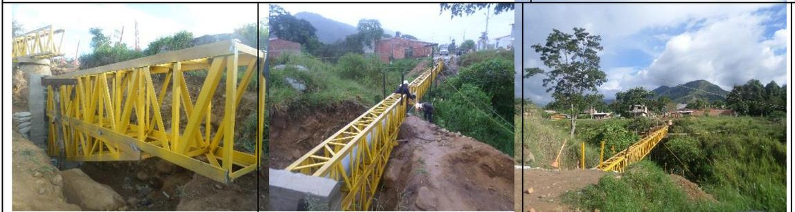
Paso Elevado L= 41,50 ml, tubería de 12"
