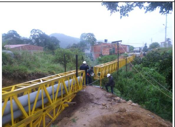
**Foto 30.** Instalación de Tubería de 12" entre pozo 39-40
