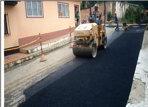
**Foto 37.** Compactacion Pavimento Asfalto
