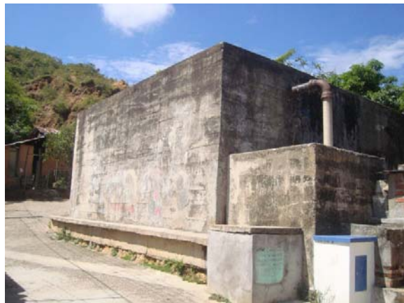
Foto 18. Tanque 12 de Octubre.
