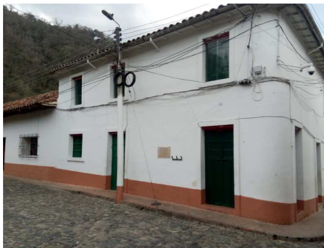
Figura 12. Sede Principal.Fuente. Autor del proyecto
