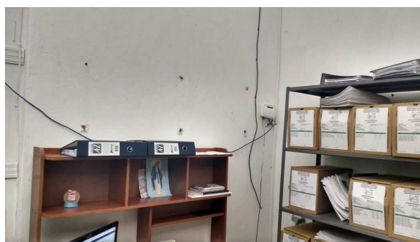
Figura 17. Evidencia de la no existencia de tomas para cada área de trabajo. Fuente. Autor del proyecto
